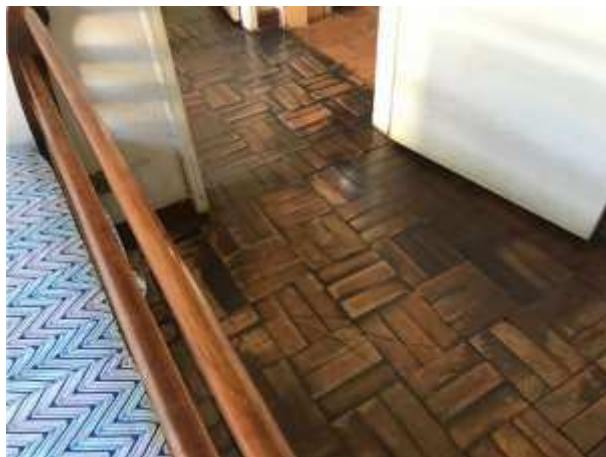
Imagem 164: Vista do piso de madeira do dormitório 01 e vista de parte do piso do corredor de entrada.
