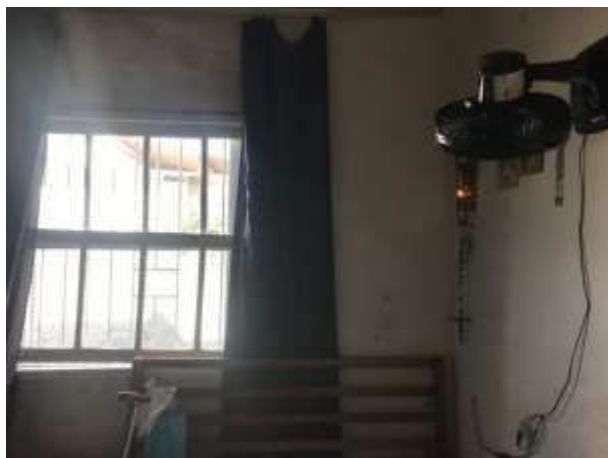
Imagem 151: Janela do dormitório 01 a ser removida, sem reaproveitamento.
