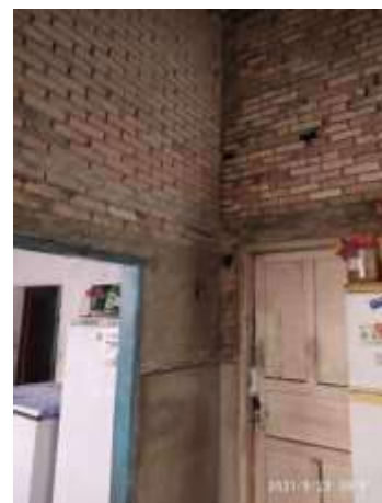
Imagem 271: Cozinha, área que receberá reboco e pintura de acabamento.
