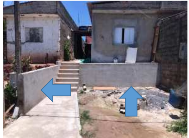
Imagem 205: Mureta no recuo frontal na divisa com o vizinho do lado esquerdo de quem da rua olha para a residência e a mureta que faceia a fachada frontal. Ambas receberão pintura acrílica.
