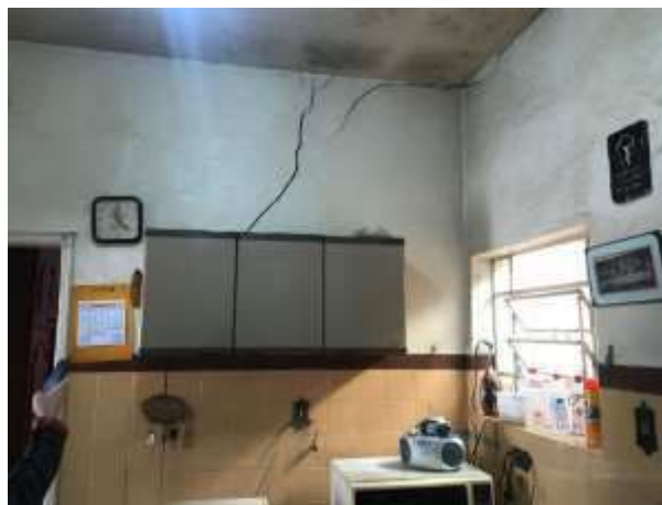
Imagem 152: Janela (J4) da cozinha a ser removida, sem reaproveitamento.
