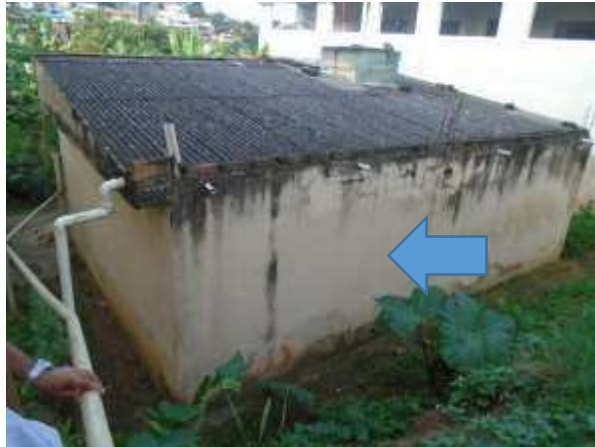
Imagem 86: Fachada frontal a ser pintada.
