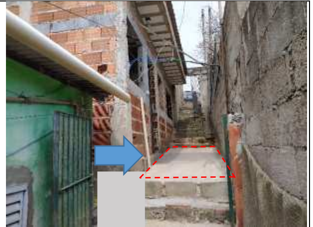
Imagem 55: Piso do corredor externo onde serão instaladas a primeira caixa de inspeção e uma caixa de gordura.
