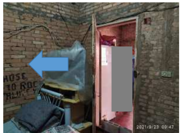
Imagem 259: Chapisco em emboço (reboco) nas paredes do dormitório 1, até altura do telhado.
