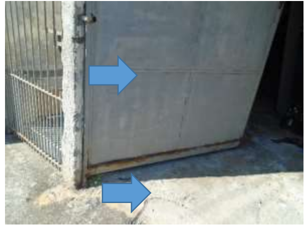
Imagem 324: Piso da garagem a ser demolido e portão a ser retirado.
