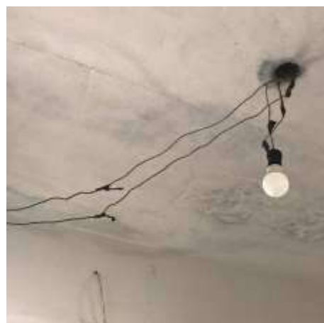
Imagem 295: Instalação de plafonier.
