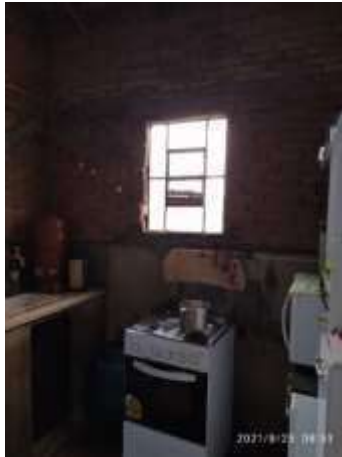
Imagem 249: Janela da cozinha a ser removida/demolida, sem reaproveitamento.
