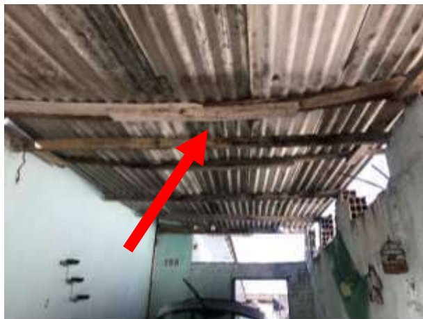
Imagem 110: Indicação da cobertura da Garagem que será refeita.
