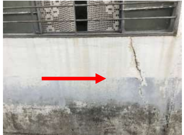
Imagem 303: Trinca em área externa que será reparada e receberá pintura posteriormente.
