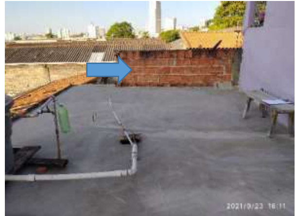
Imagem 315: Revestir com reboco e emboço a alvenaria já existente.
