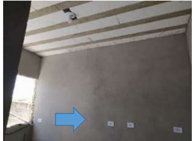
Imagem 53: Parede da cozinha da 1ª residência onde será instalado o tampo da cuba.
