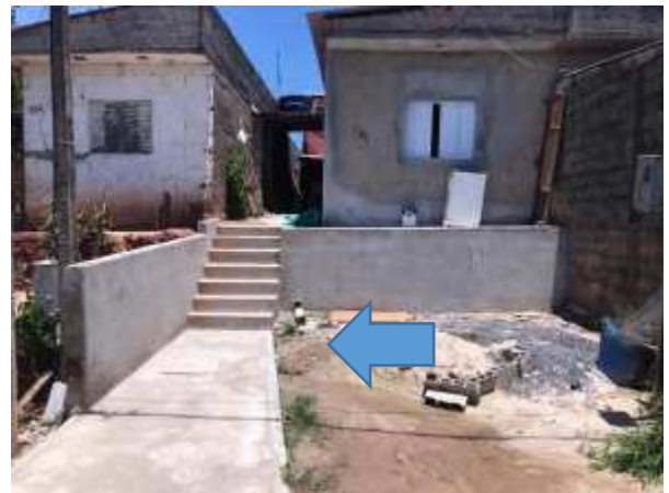
Imagem 197: Localização da instalação do tubo de esgoto de 100mm para a captação das águas pluviais.
