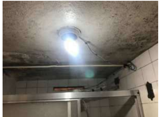
Imagem 158: Demolir a argamassa da laje do banheiro 01.
