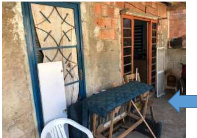
Imagem 15: Varanda: seta indicando a localização onde deverá ser construída a rampa de concreto.
