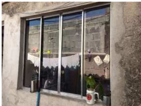
Imagem 181: Janela da cozinha a ser removida.
