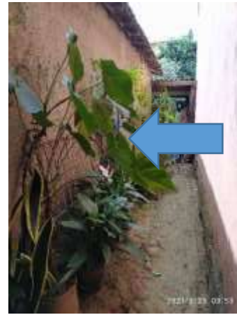
Imagem 261: Fachada lateral (esquerda) a ser rebocada.
