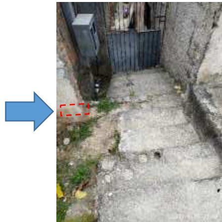
Imagem 29: Posição da execução do pilar da nova alvenaria do portão.
