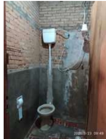
Imagem 269: Interior do banheiro.
