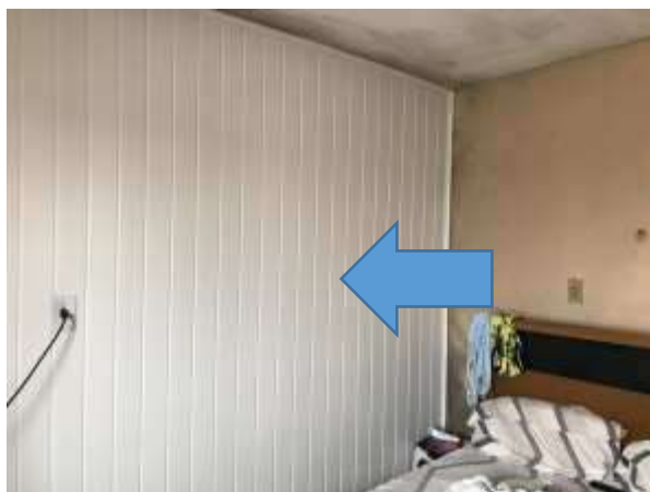
Imagem 81: Aplicar reboco impermeabilizante.
