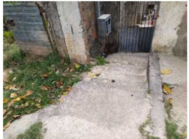
Imagem 22: Vista da escada existente (vista da calçada) que será aterrada.
