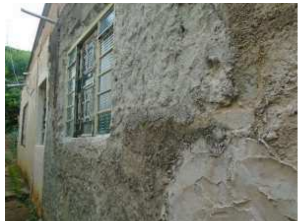
Imagem 80: Rebocar as paredes externas (cozinha).
