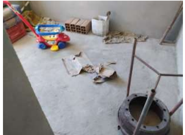
Imagem 46: Piso da cozinha da 1ª residência que receberá piso cerâmico (marca Unigress, 0,54x0,54m) e rodapé.
