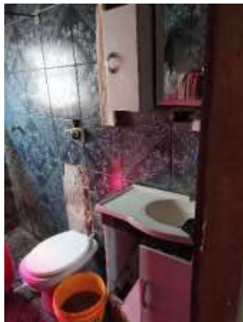
Imagem 9: Aparelhos sanitários a serem retirados, assim como a demolição da argamassa dessa parede que faz divisa com o dormitório 02 para a substituição da tubulação hidráulica que atende as peças sanitárias.
