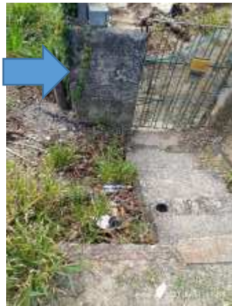
Imagem 11: Posição da execução do pilar da nova alvenaria do portão.
