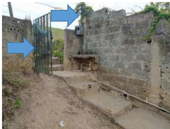
Imagem 4: Portão e poste de energia a serem retirados. Posteriormente o portão será reinstalado.
