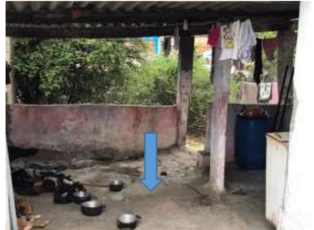
Imagem 283: Piso cerâmico a ser instalado.
