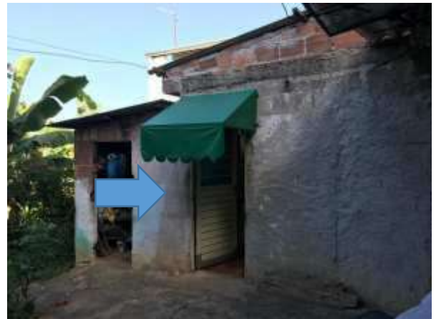
Imagem 89: Aplicar pintura de acabamento em toda a extensão desta face.
