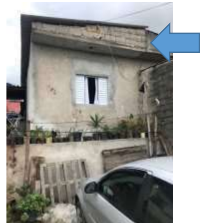
Imagem 191: Empena da fachada frontal a receber chapisco e emboço.
