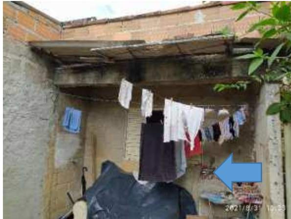
Imagem 77: Rebocar as paredes externas.
