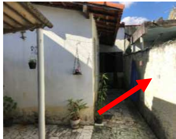
Imagem 123: Indicação do muro lateral que receberá os trabalhos de chapisco, emboço e pintura.
