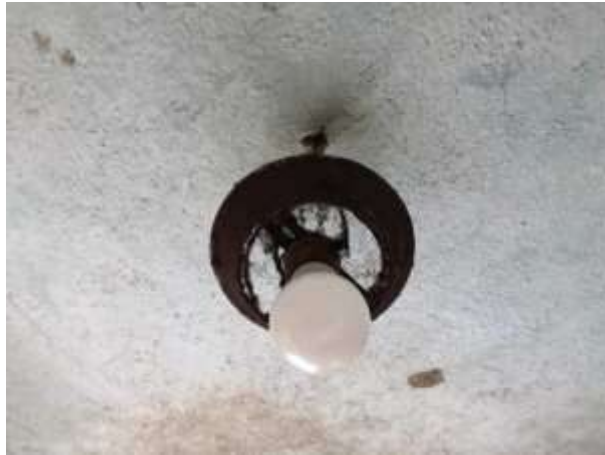
Imagem 276: Cozinha. Plafonier ser removido.
