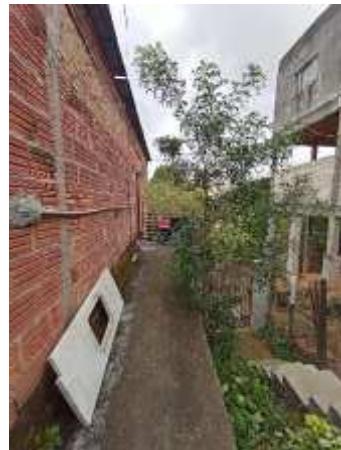
Imagem 2411: Rebocar essa fachada de maneira completa.
