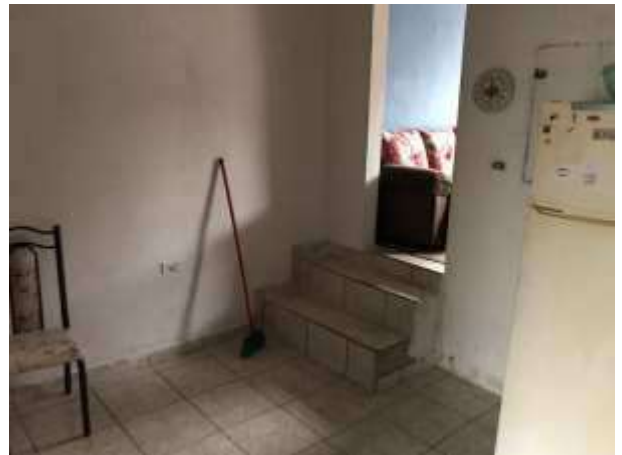
Imagem 279: Degraus a serem removidos e regularizados.
