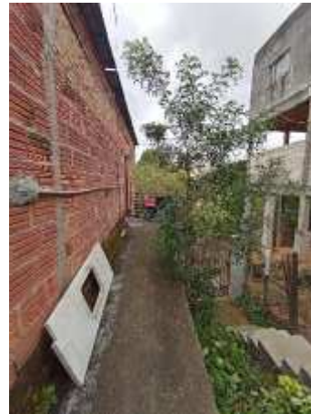
Imagem 239: Retirar cabos elétricos desta fachada também. Os cabos serão recolocados ao final das tarefas.
