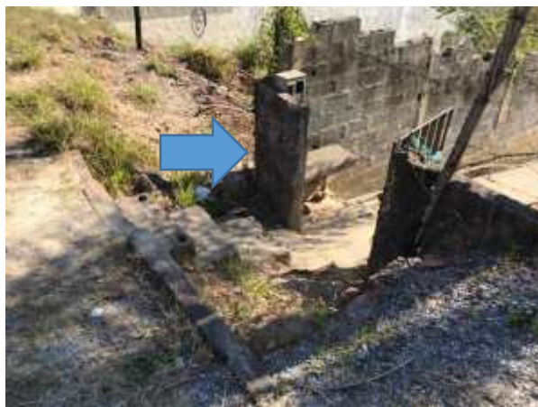
Imagem 3: Alvenaria do portão a ser demolida.
