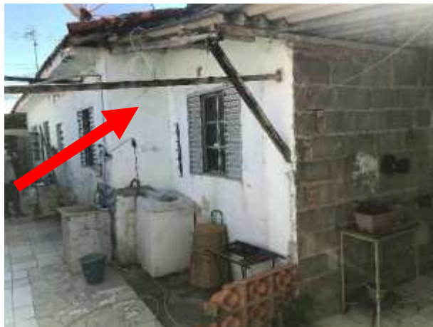
Imagem 122: Indicação das faces externas da casa que receberão pintura.
