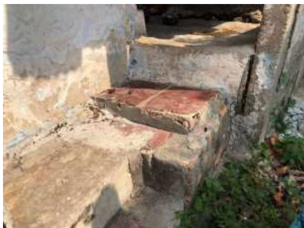
Imagem 280: Degraus a serem removidos e regularizados.
