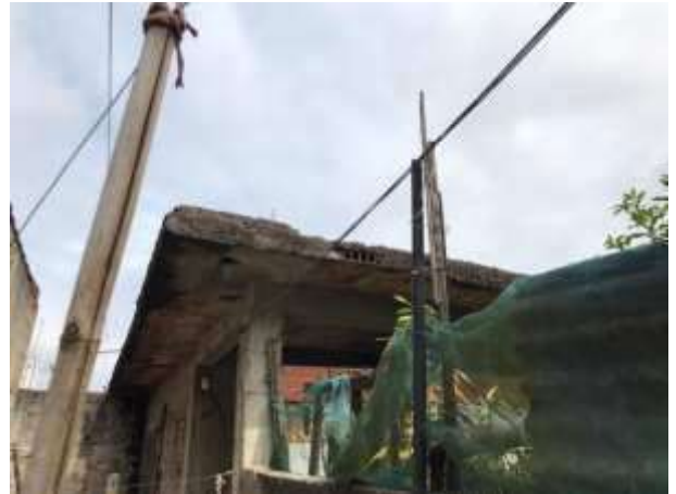
Imagem 291: Laje exposta, instalação de telhado de fibrocimento.
