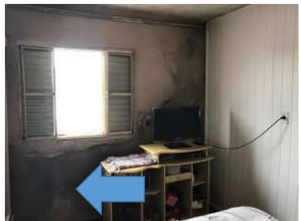
Imagem 82: Aplicar reboco impermeabilizante.
