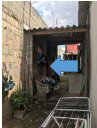
Imagem 190: Muro da área de serviço na divisa com o vizinho a receber chapisco e emboço.
