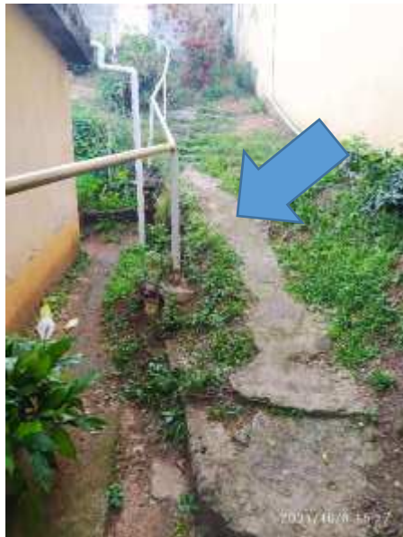
Imagem 73: Piso de concreto a ser demolido.
