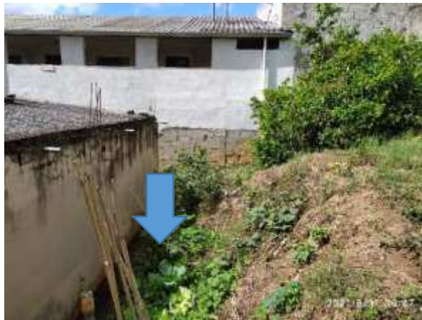
Imagem 75: As canaletas serão instaladas ao pé do talude, próximas à fachada da residência que é paralela à entrada do lote.
