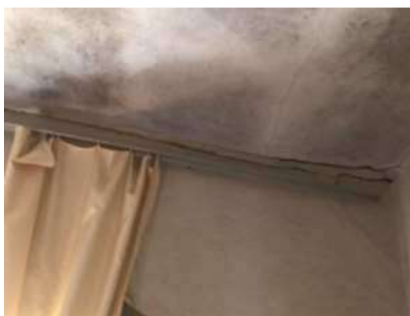
Imagem 163: Estuque do dormitório 02 a ser demolido.
