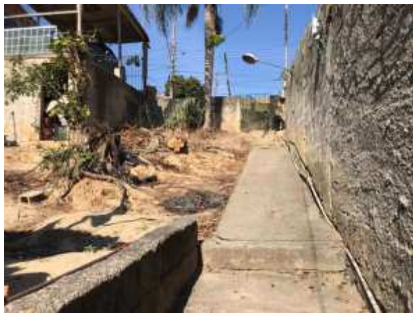
Imagem 1: Rampa e escadas existentes que serão aterradas.
