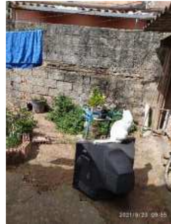
Imagem 254: Fundos do imóvel, onde deve ser construída a mureta.
