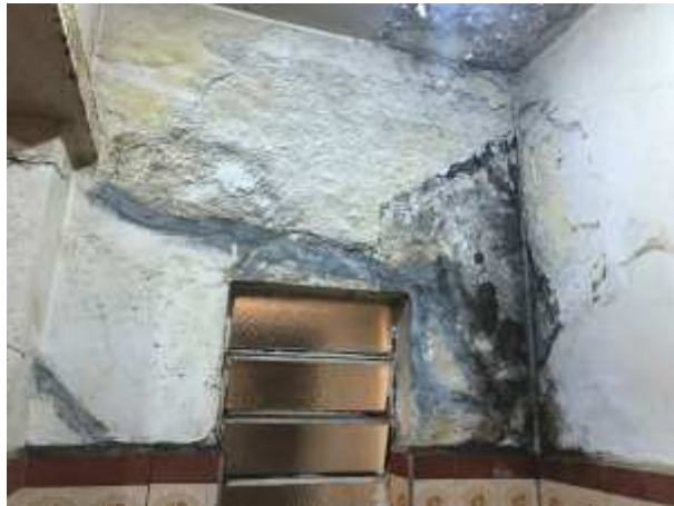
Imagem 157: Demolir a argamassa destas duas paredes na cozinha.
