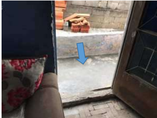
Imagem 282: Piso cerâmico a ser instalado.
