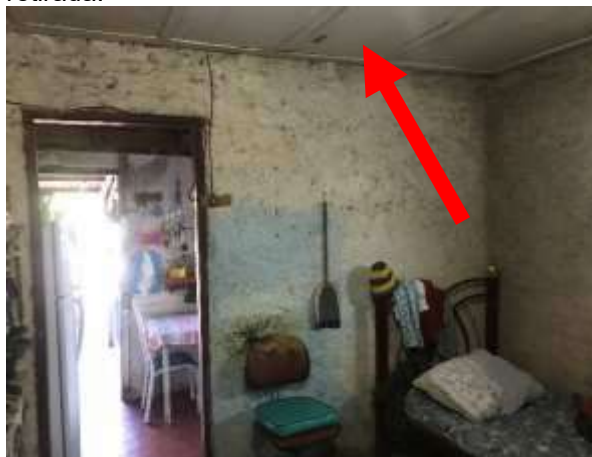
Imagem 215: Visão geral do Forro do Quarto 2 a ser removido.
