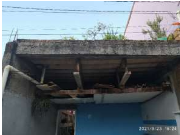
Imagem 310: Remoção da estrutura de madeira, com reaproveitamento.
