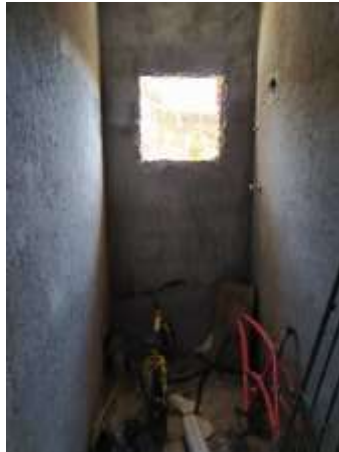
Imagem 52: Banheiro da 1ª residência que receberá os metais e louças sanitárias.
