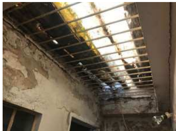
Imagem 160: Cobertura e grade do corredor em frente ao banheiro 01 a serem removidas, sem reaproveitamento.
