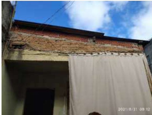
Imagem 238: Retirar cabos elétricos para execução dos serviços.
