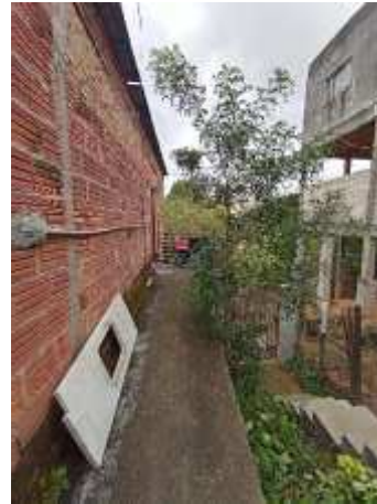
Imagem 245: Construir guarda-corpo em alvenaria.
