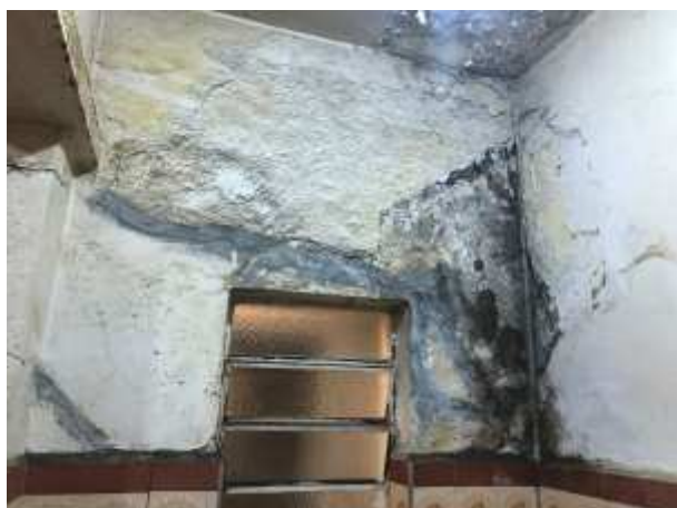
Imagem 153: Janela (J5) da cozinha a ser removida, sem reaproveitamento.
