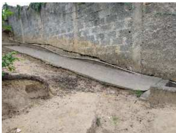
Imagem 5: Vista lateral da rampa existente.
