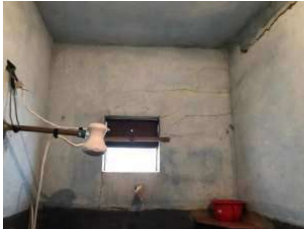
Imagem 290: Substituição da janela existente.
