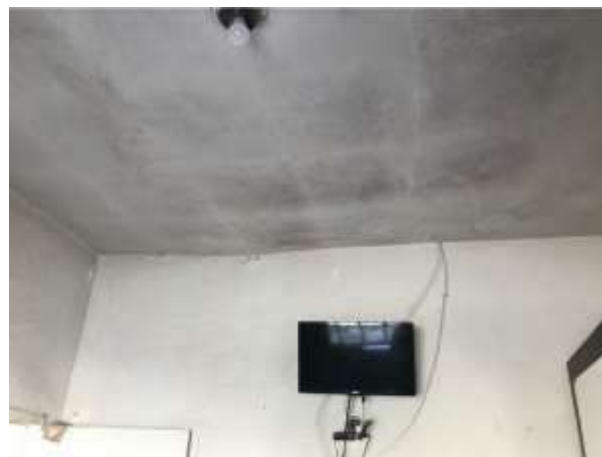
Imagem 162: Estuque do dormitório 01 a ser demolido.
