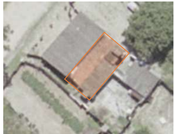
Imagem 224: Visão aérea da cobertura a ser edificada.
