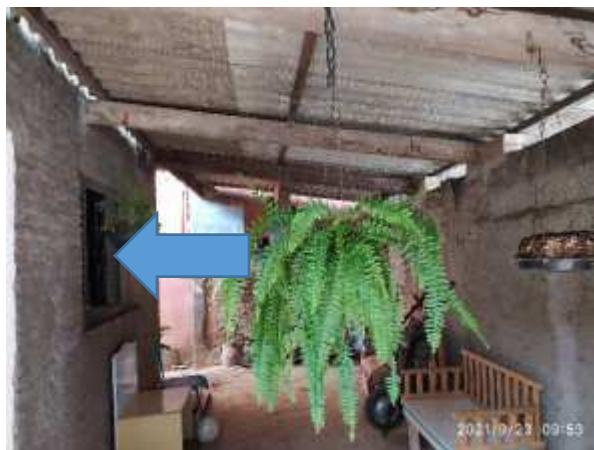
Imagem 262: Fachada frontal que receberá reboco.
