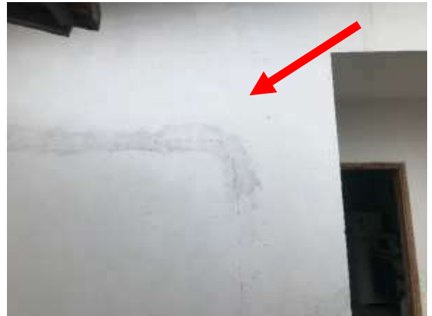
Imagem 305: Trinca em área externa que será reparada e receberá pintura posteriormente.
