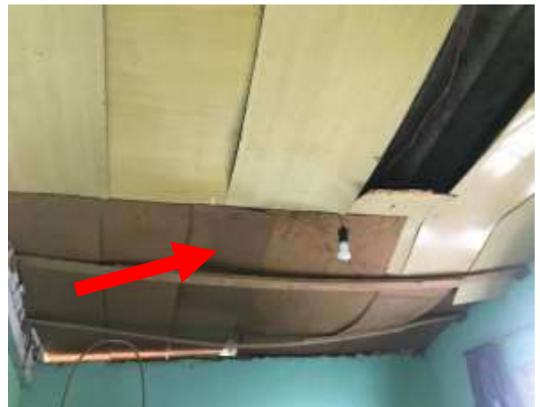
Imagem 98: Visão do forro do Quarto 3 que deverá ser substituído por forro de PVC após o aumento do referido ambiente.
