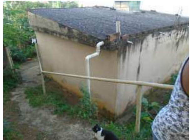
Imagem 87: Fachada lateral esquerda que receberá pintura de acabamento.
