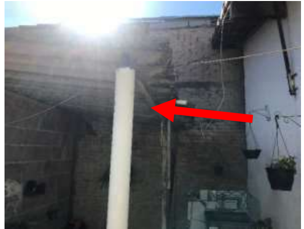
Imagem 96: Vista do telhado da área de serviço que será requalificado juntamente com a cobertura do Quarto 3.
