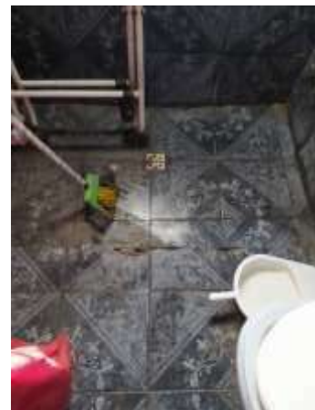
Imagem 2: Piso do box do banheiro que receberá um pequeno aterro.
