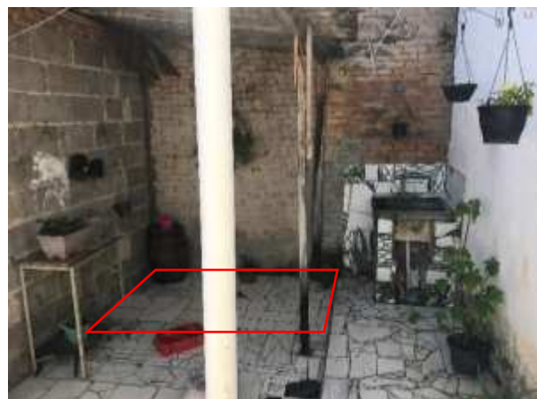
Imagem 119: Indicação da regularização do piso a ser feita
