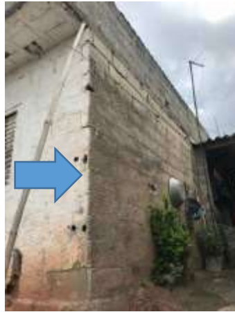
Imagem 198: Muro de divisa com o vizinho do lado esquerdo de quem da rua olha para a residência a receber pintura acrílica.
