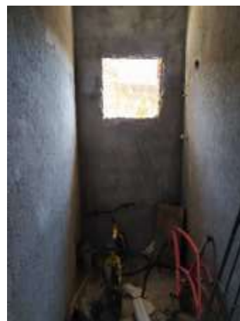
Imagem 32: Vão da janela do banheiro da 1ª residência.
