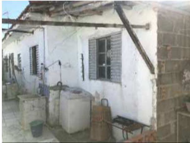
Imagem 106: Vista da Janela J6 a ser readequada.
