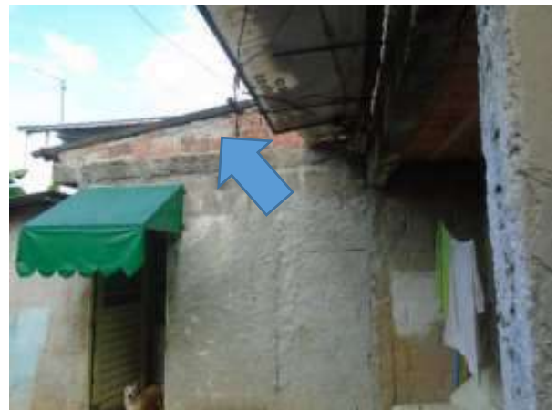
Imagem 64: Cobertura da cozinha que também deverá ser demolida (telhas, madeiramento e alvenaria).
