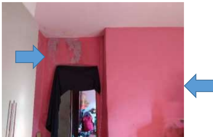
Imagem 19: Parede do dormitório 02 que receberá nova pintura.
