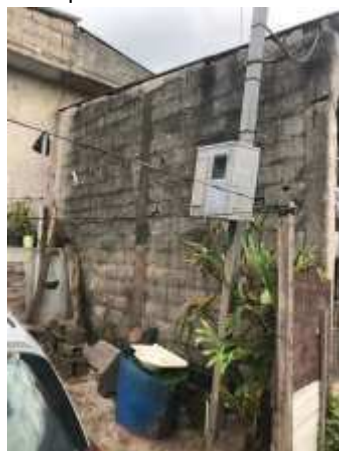
Imagem 202: Muro de divisa, no recuo frontal, com o vizinho do lado direito de quem da rua olha para a residência que receberá pintura acrílica.
