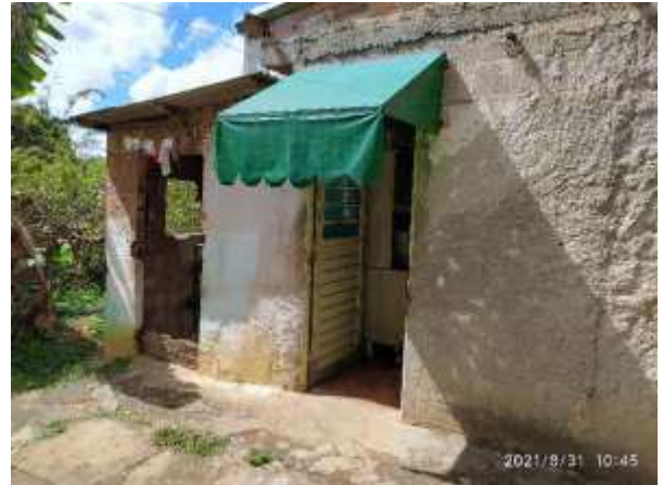
Imagem 78: Rebocar as paredes externas.
