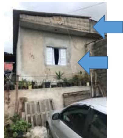
Imagem 201: Empena e fachada frontal a receberem pintura acrílica.
