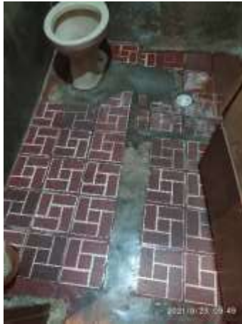
Imagem 264: Foto do piso do banheiro.
