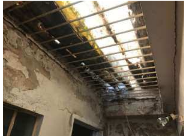
Imagem 173: Executar nova cobertura, com instalação de rufo, no corredor em frente ao banheiro 01.
