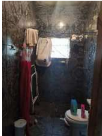
Imagem 7: Piso cerâmico e azulejos a serem demolidos.
