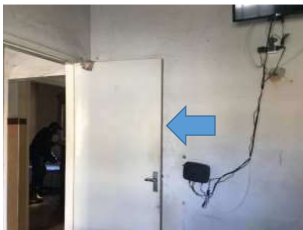
Imagem 149: Remoção somente da folha da porta de madeira do dormitório 01, sem reaproveitamento.
