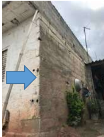
Imagem 188: Muro de divisa com o vizinho do lado esquerdo de quem da rua olha para a residência a receber chapisco e emboço.
