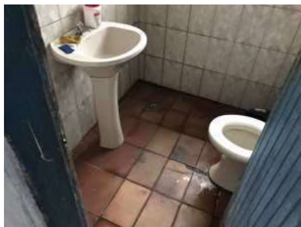
Imagem 275: Banheiro. Piso cerâmico a ser removido.
