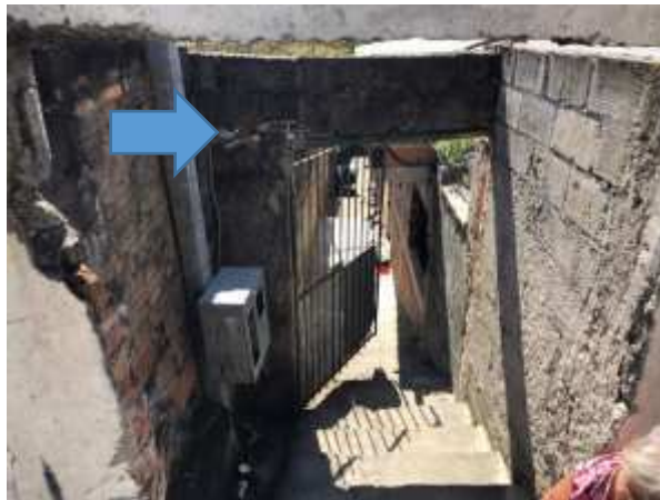
Imagem 24: Alvenaria do atual portão a ser demolida.
