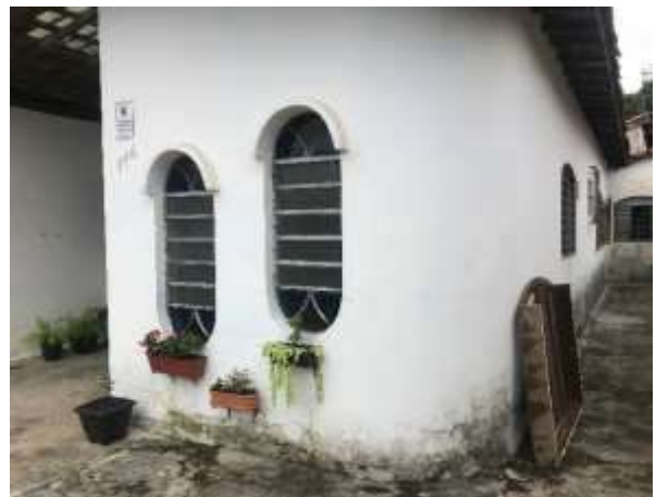
Imagem 297: Vista da entrada do imóvel.
