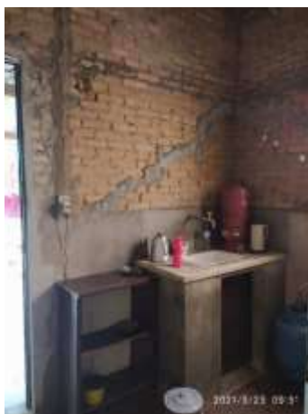
Imagem 270: Cozinha – paredes em L, que receberão revestimento cerâmico de forma parcial e pintura de acabamento.
