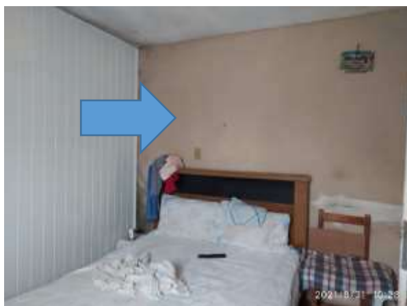
Imagem 69: Remover o reboco de maneira parcial, ver projeto.
