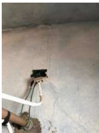
Imagem 294: Substituição de todos os terminais, do ponto de energia.
