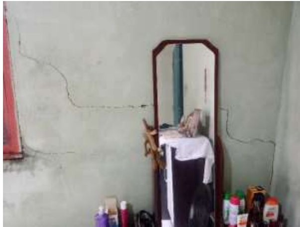
Imagem 2422: Parede do dormitório 1.
