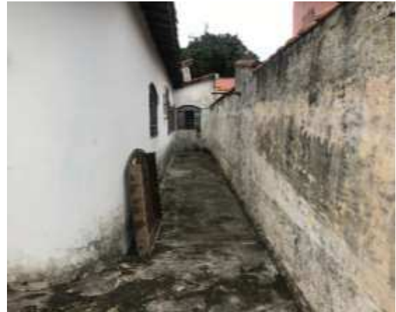
Imagem 309: lado externo da casa.
