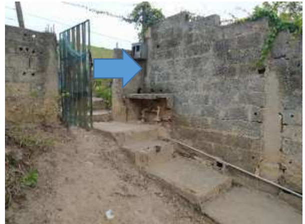
Imagem 12: Posição da execução do pilar da nova alvenaria do portão.
