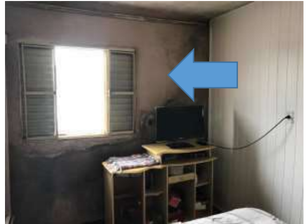
Imagem 72: Para instalação do quadro de distribuição, será necessária a demolição de uma pequena parcela de alvenaria.
