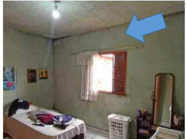
Imagem 2433: Parede do dormitório 1
