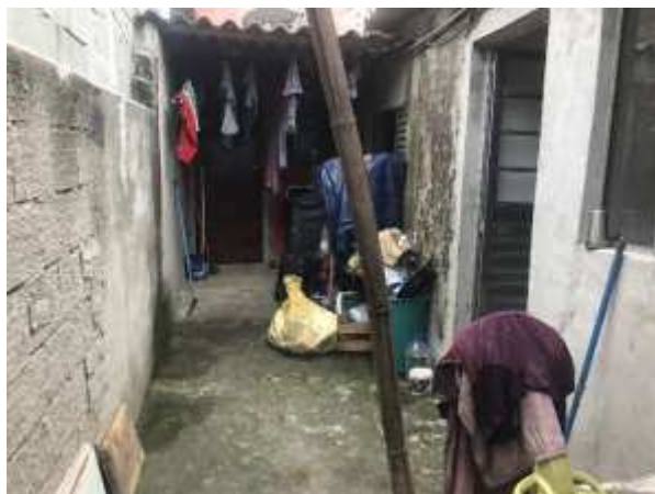
Imagem 183: Piso de cimento do corredor externo lateral à residência que deverá ser todo demolido.
