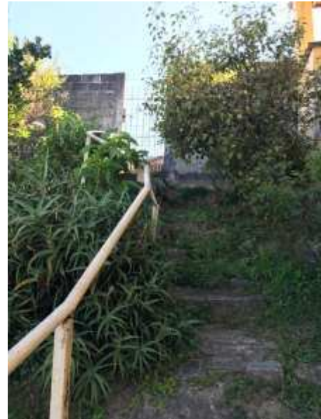
Imagem 74: Remover o corrimão existente desde o início, junto ao portão do imóvel até o término da rampa (piso de concreto).
