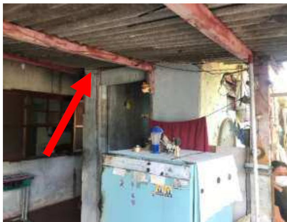
Imagem 211: Visão interna do telhado a ser removido.
