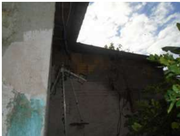
Imagem 79: Rebocar as paredes externas (Área de serviço e cozinha).
