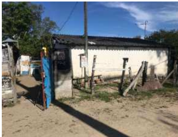
Imagem 207: Fachada do imóvel.
