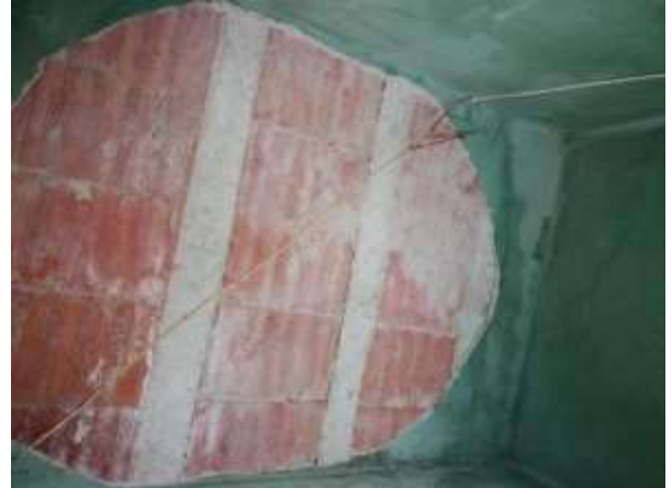
Imagem 237: Remover o reboco, de maneira completa, do teto da área de circulação.
