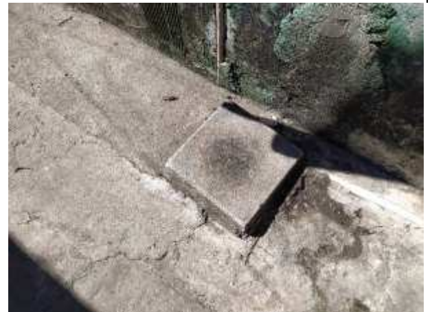
Imagem 57: Caixa de inspeção existente no final do corredor externo.
