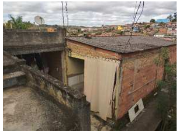
Imagem 235: Vista lateral do telhado a ser demolido.
