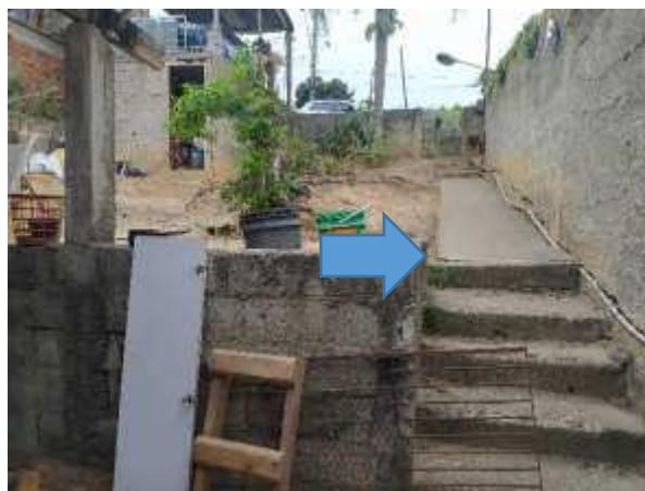
Imagem 6: Vista da rampa e parte da escada existente.
