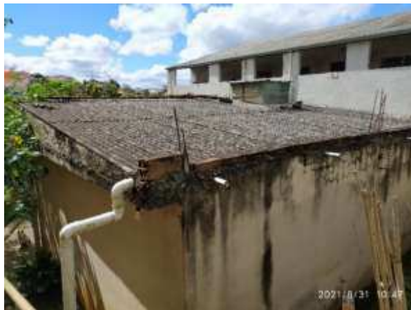
Imagem 63: Telhado, alvenaria de cobertura e caixa d'água a serem removidos/demolidos. Esta área contempla dormitório, sala e banheiro.
