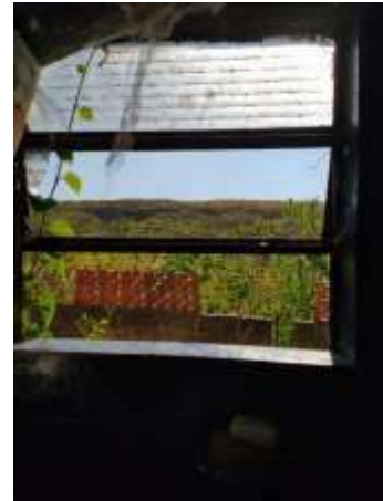
Imagem 8: Janela do banheiro a ser removida.
