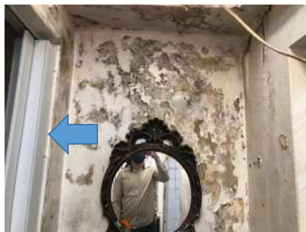
Imagem 150: Remoção da porta sanfonada de PVC do banheiro 01, sem reaproveitamento.
