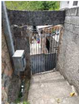
Imagem 27: Portão a ser retirado e poste de energia a ser removido, sem reaproveitamentos.
