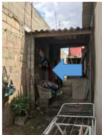
Imagem 200: Muro da área de serviço na divisa com o vizinho a receber pintura acrílica.
