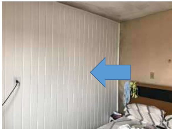
Imagem 67: Remover o forro de PVC e o reboco, de maneira completa, desta parede.
