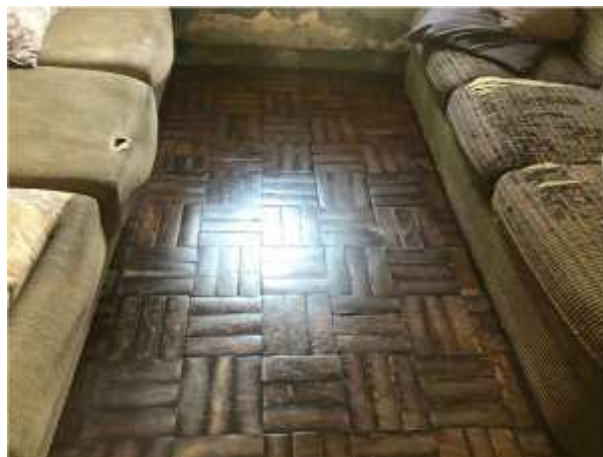
Imagem 165: Piso de madeira da sala a ser removido, sem reaproveitamento.
