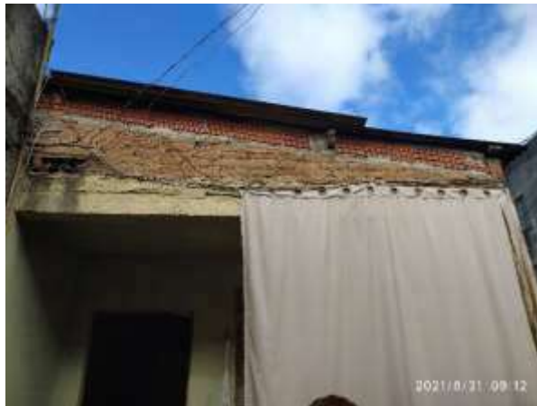
Imagem 2400: Revestir com reboco e emboço a alvenaria de cobertura recém construída.
