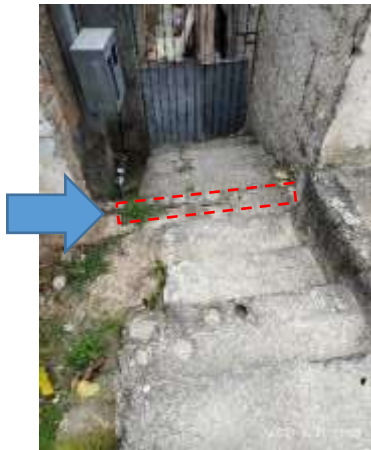
Imagem 28: Posição da nova alvenaria do portão a ser executada (ver projeto arquitetônico).
