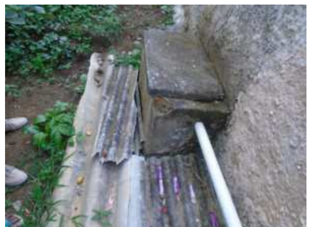
Imagem 70: Caixa de gordura a ser demolida.
