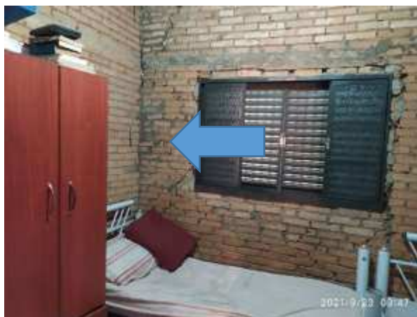
Imagem 258: Dormitório 1 a ser rebocado.
