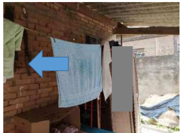
Imagem 263: Fachada dos fundos onde deve ser aplicado chapisco e emboço.
