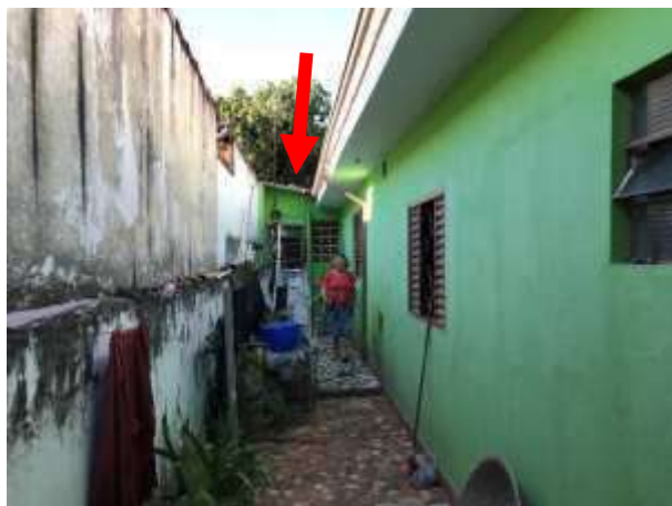
Imagem 132: Indicação do telhado a ser removido.
