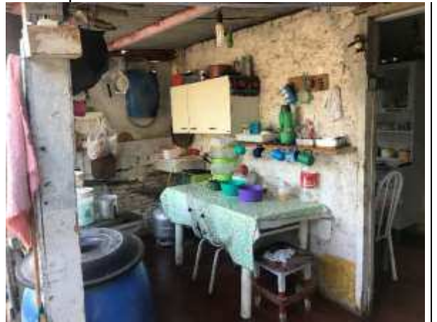
Imagem 220: Área prevista para fechamento de alvenaria.
