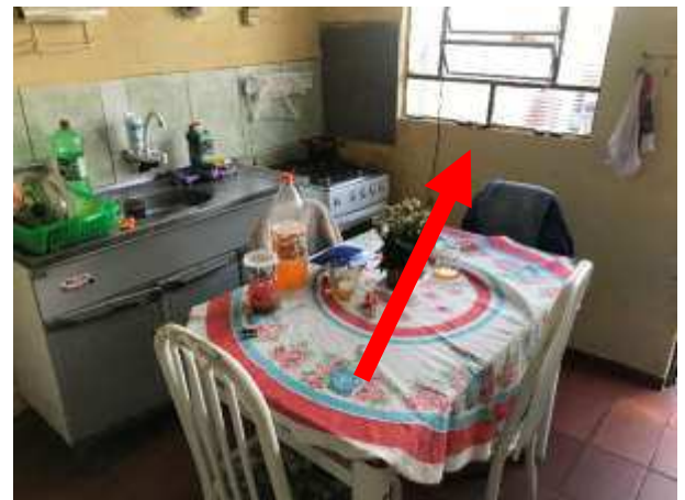
Imagem 115: Parede da cozinha que receberá revestimento cerâmico.
