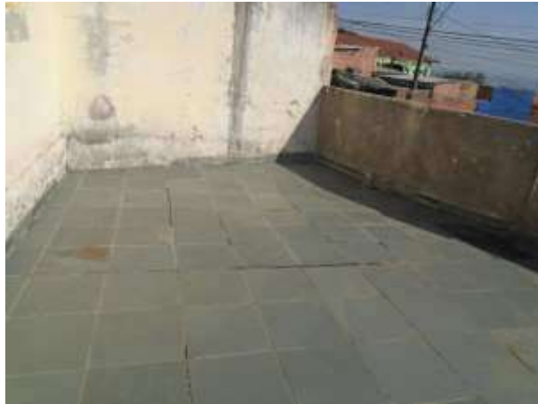
Imagem 323: Laje da varanda a ser demolida.
