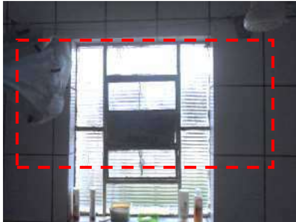
Imagem 71: Adequação do vão existente para nova esquadria.
