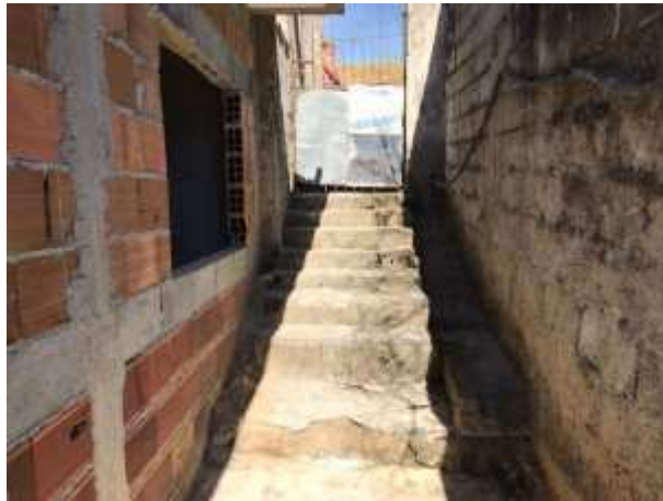
Imagem 50: Vista da escada atual, que será aterrada para a execução da nova escada de acesso às residências.
