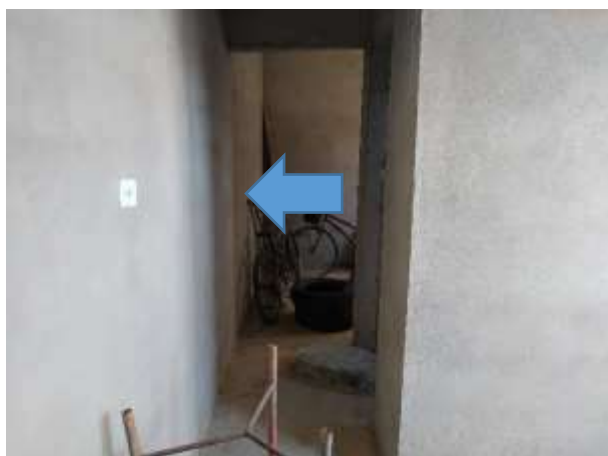
Imagem 60: Posição de instalação do novo quadro de distribuição de energia na 1ª residência.
