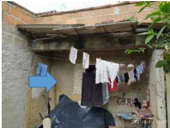
Imagem 88: Executar a pintura inclusive nos tetos externos (laje).
