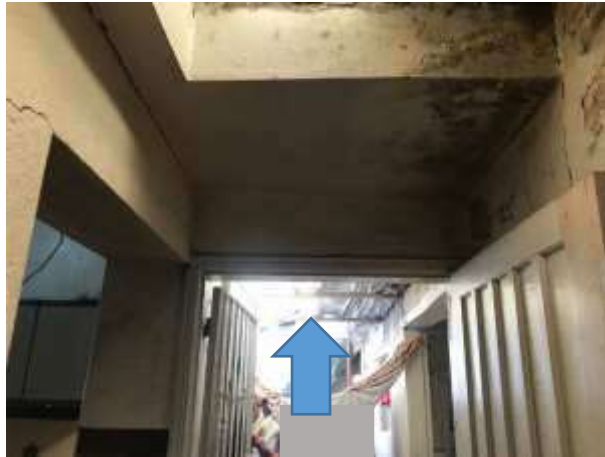
Imagem 172: Executar nova cobertura, com instalação de rufo, em frente à área de serviço.
