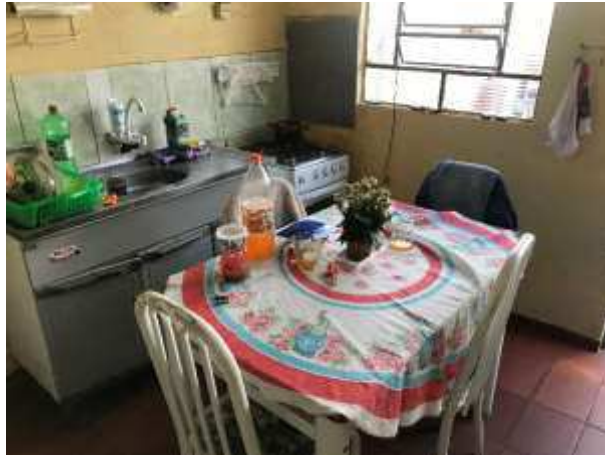
Imagem 101: Remover os revestimentos e rodapés das paredes da imagem, pois receberão novo revestimento cerâmico.
