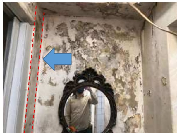
Imagem 148: Parte da parede do banheiro 01 que será demolida para a ampliação do referido ambiente.
