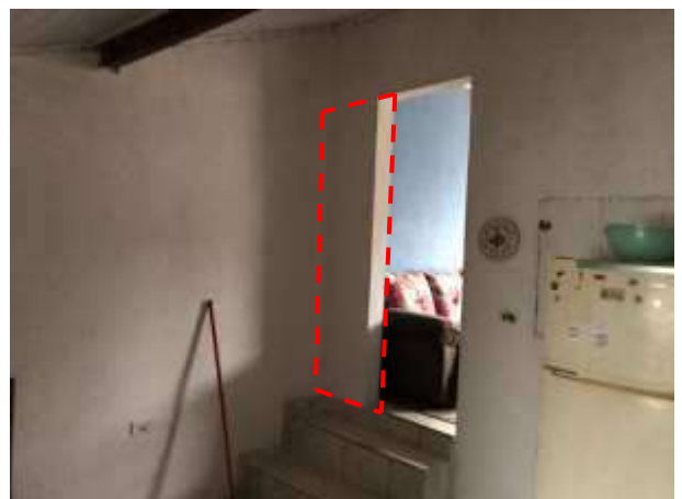
Imagem 281: Parede a ser removida.
