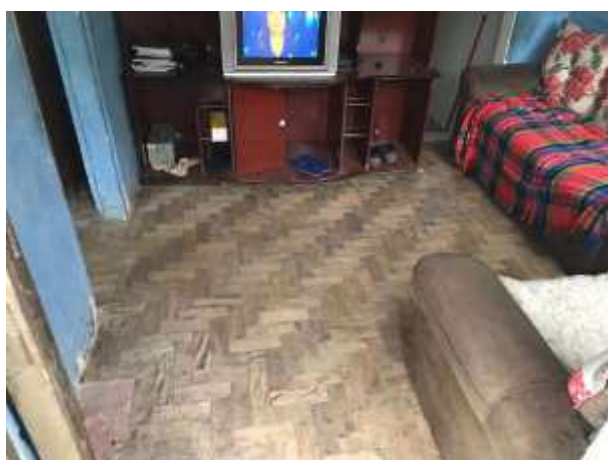
Imagem 272: Sala. Taco a ser removido
