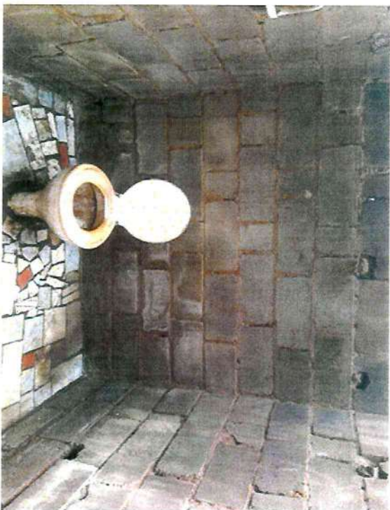
Foto antes banheiro
