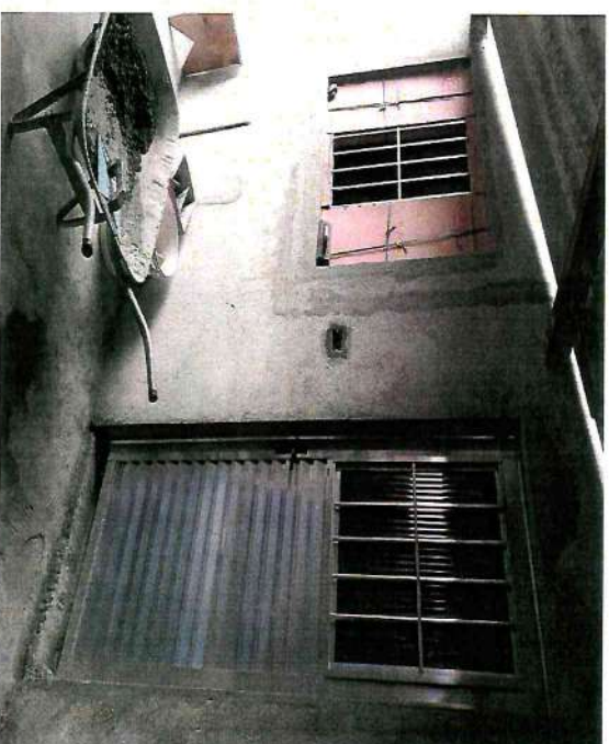
Obra em andamento
