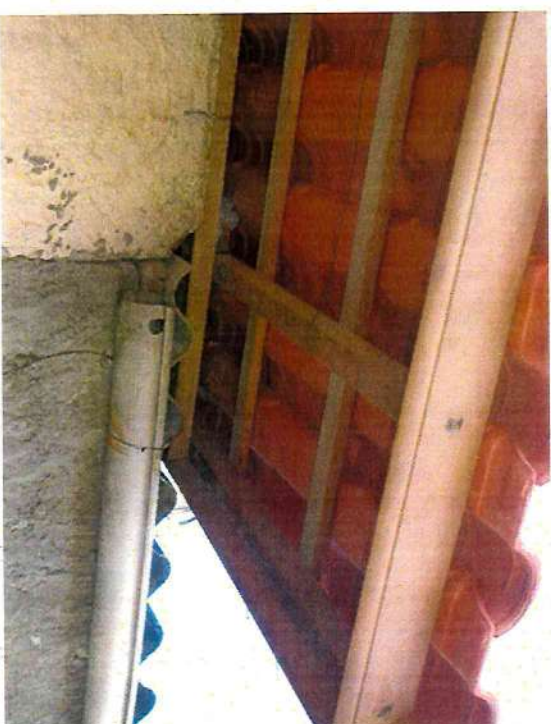
Vista por fora do novo telhado.
