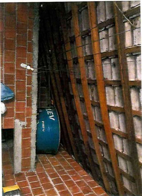
Vista da laje em cima do banheiro cobertura por dentro da casa.
