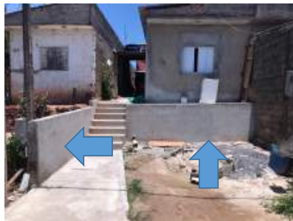
Imagem 205: Mureta no recuo frontal na divisa com o vizinho do lado esquerdo de quem da rua olha para a residência e a mureta que faceia a fachada frontal. Ambas receberão pintura acrílica.
