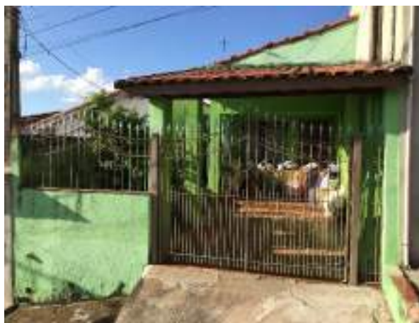
Imagem 124: Fachada do imóvel em questão e onde deve ser colocada a placa de obras.
