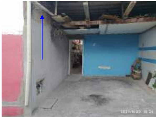
Imagem 316: Rebocar o teto e as demais frações de parede da garagem que não possuem esse tipo de acabamento.
