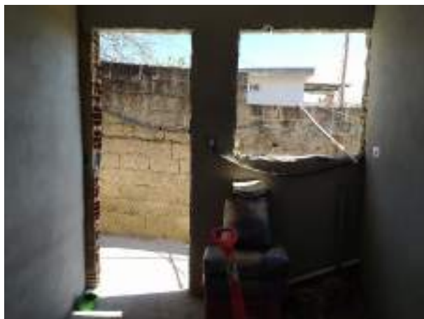
Imagem 30: Vãos da porta e janela da cozinha da 1ª residência.
