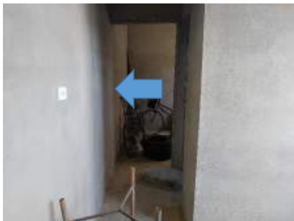
Imagem 26: Vista da parede do corredor interno da 1ª residência onde deverá ser instalado o novo quadro de distribuição de energia.
