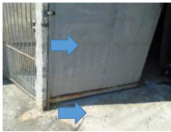
Imagem 324: Piso da garagem a ser demolido e portão a ser retirado.
