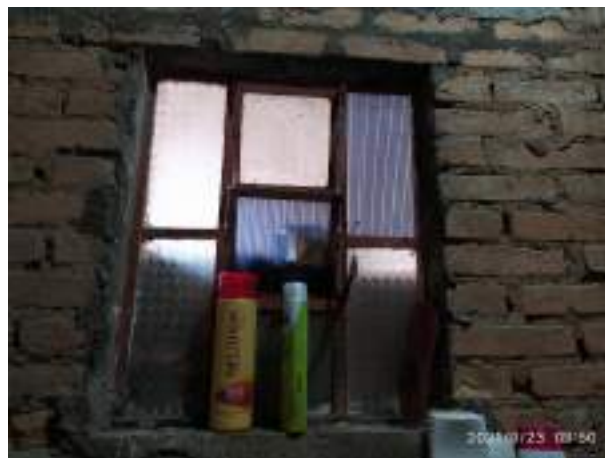
Imagem 250: Janela do banheiro a ser removida/demolida sem reaproveitamento.
