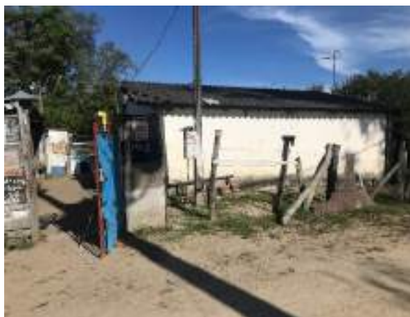
Imagem 207: Fachada do imóvel.
