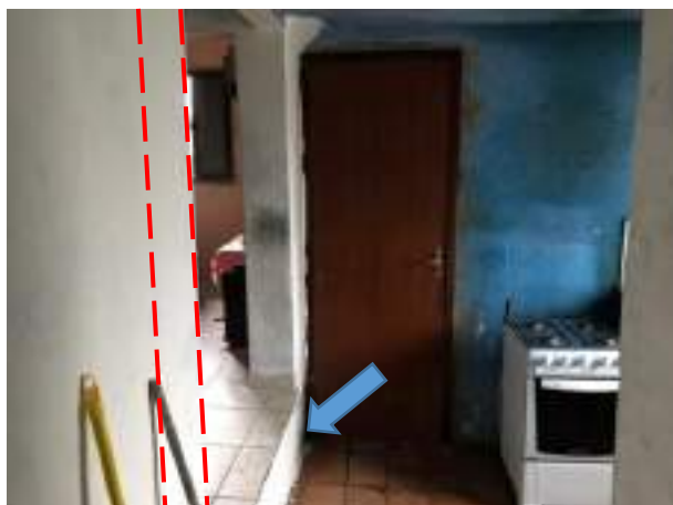
Imagem 278: Degrau a ser demolido e regularizado. Pontilhado indica trecho da parede a ser demolida.
