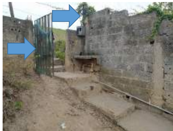
Imagem 4: Portão e poste de energia a serem retirados. Posteriormente o portão será reinstalado.
