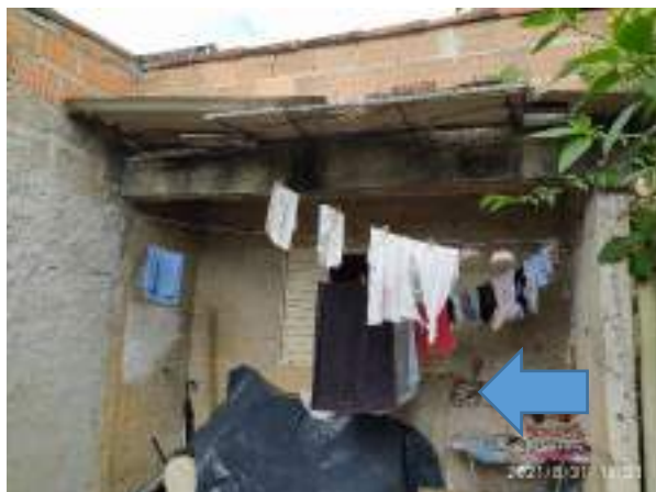
Imagem 77: Rebocar as paredes externas.
