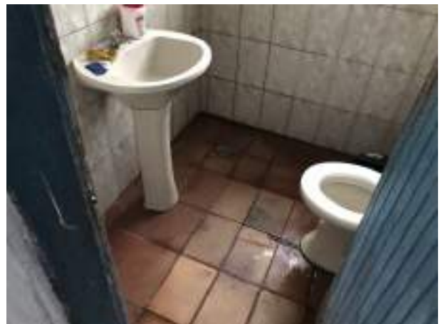
Imagem 275: Banheiro. Piso cerâmico a ser removido.
