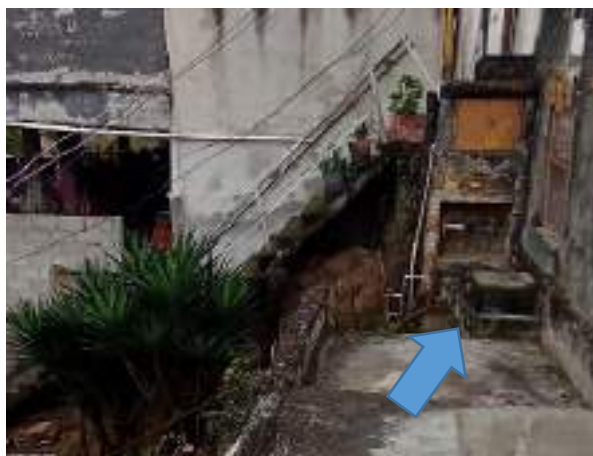
Imagem 236: Remoção dos degraus da entrada do portão social.
