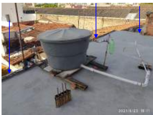
Imagem 312: Laje onde deve ser construída a alvenaria de cobertura (guarda-corpo).
