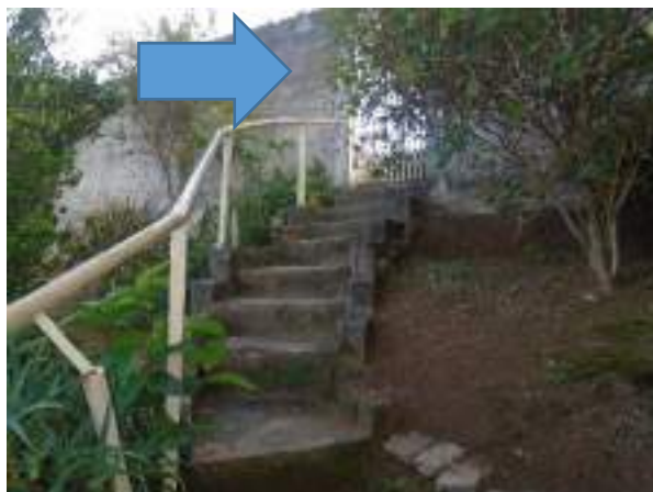
Imagem 84: Instalar arandela junto ao portão social e interruptor paralelo.
