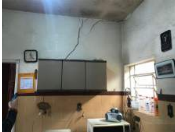
Imagem 177: Paredes da cozinha a serem pintadas (acima da barra de azulejo existente).
