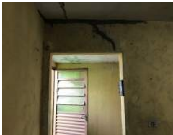
Imagem 143: Quarto 3, local a ser pintado após os reparos indicados.
