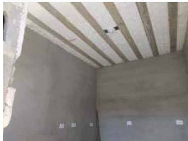
Imagem 41: Laje da cozinha da 1ª residência que receberá gesso.
