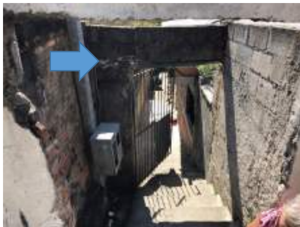
Imagem 24: Alvenaria do atual portão a ser demolida.
