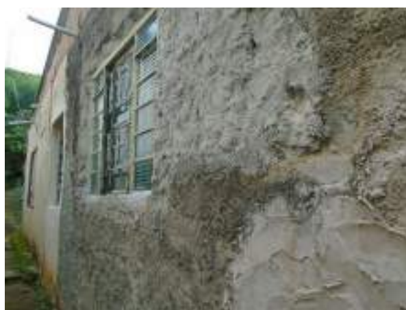
Imagem 80: Rebocar as paredes externas (cozinha).
