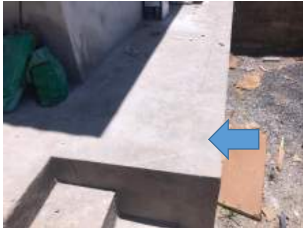
Imagem 187: Posição onde deverá ser instalada a grelha para a captação das águas pluviais vindas do corredor externo lateral à residência.
