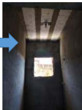
Imagem 39: Parte superior das paredes do banheiro da 1ª residência que receberão emboço interno desempenado para pintura.
