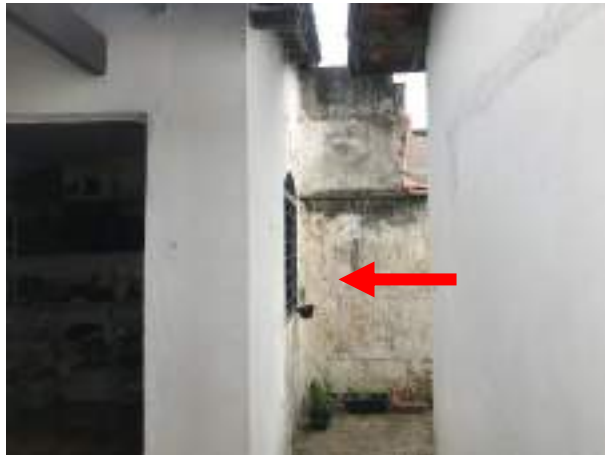
Imagem 304: Reparo em trinca no muro externo anteriormente ao trabalho de pintura.
