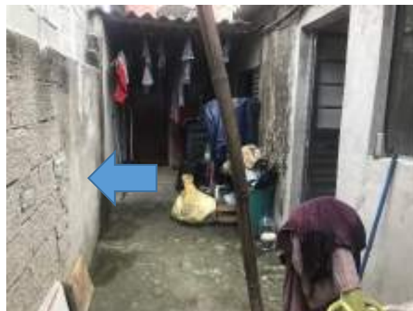
Imagem 189: Muro de divisa com o vizinho do lado esquerdo de quem da rua olha para a residência a receber chapisco e emboço.
