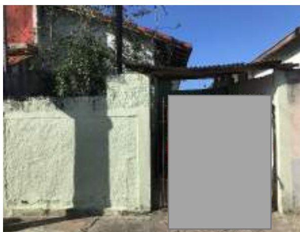
Imagem 93: Fachada do imóvel em questão e onde deve ser colocada a placa de obras.
