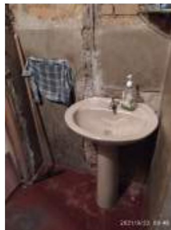
Imagem 267: Interior do lavabo – barra impermeável até 1,5m e pintura no restante da área (acima de 1,5m).
