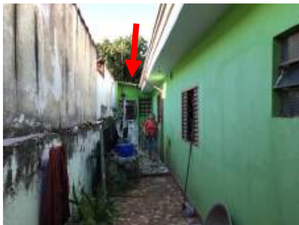
Imagem 132: Indicação do telhado a ser removido.
