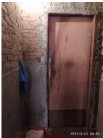
Imagem 266: Interior do lavabo (pintura a partir de 1,5m do piso).
