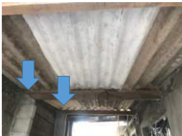
Imagem 186: Pilares que sustentam o telhado da área de serviço que deverão ter sua altura aumentada com o uso de blocos de concreto estrutural, preenchidos com concreto e armadura.
