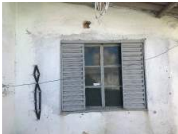
Imagem 107: Vista da Janela J6 a ser reaproveitada.
