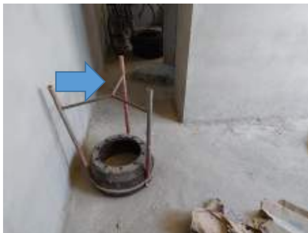
Imagem 47: Piso da circulação interna da 1ª residência que receberá piso cerâmico (marca Unigress, 0,54x0,54m) e rodapé.
