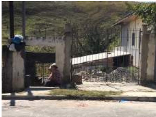
Imagem 61: Pintar com tinta acrílica todas as alvenarias do limite frontal do lote.
