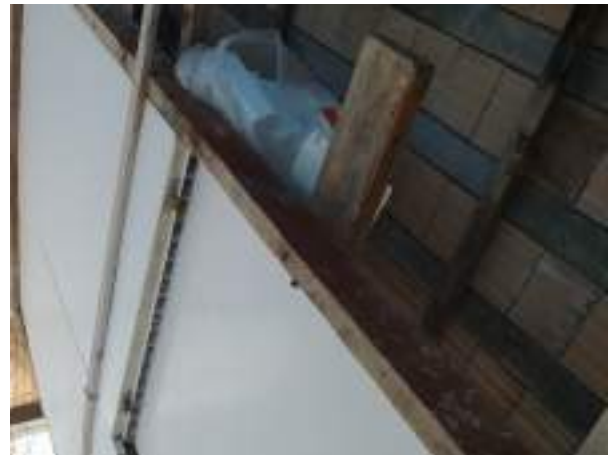
Imagem 311: Remoção da estrutura de madeira, que será recolocada ao final da obra.
