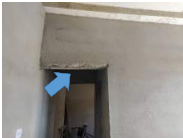
Imagem 42: Laje (não visível na foto) da circulação interna da 1ª residência que receberá gesso.
