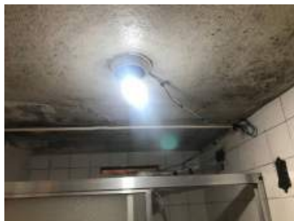
Imagem 158: Demolir a argamassa da laje do banheiro 01.
