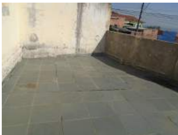
Imagem 323: Laje da varanda a ser demolida.
