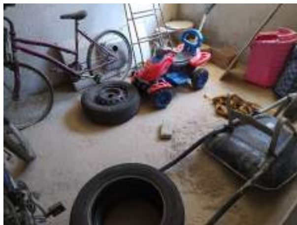
Imagem 48: Piso do dormitório da 1ª residência que receberá piso cerâmico (marca Unigress, 0,54x0,54m) e rodapé.
