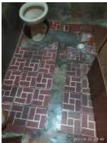
Imagem 264: Foto do piso do banheiro.
