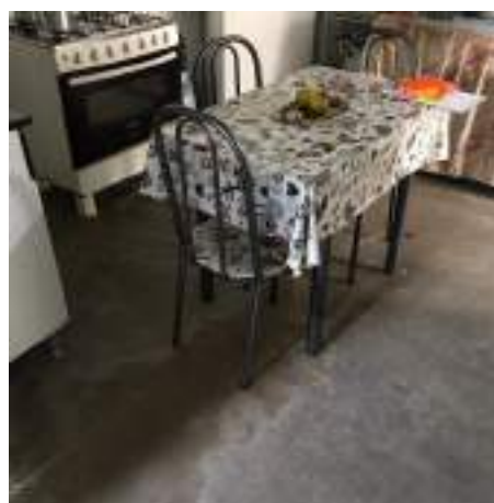
Imagem 293: Todo piso do imóvel é constituído por cimentado.
