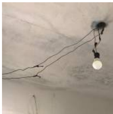
Imagem 295: Instalação de plafonier.
