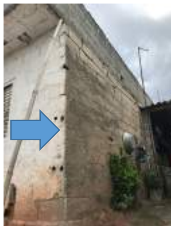
Imagem 188: Muro de divisa com o vizinho do lado esquerdo de quem da rua olha para a residência a receber chapisco e emboço.
