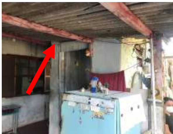
Imagem 211: Visão interna do telhado a ser removido.
