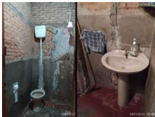
Imagem 252: Parede do banheiro com argamassa (cimento queimado) a ser demolida e que receberá, na sequência, reboco e revestimento cerâmico.
