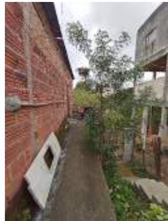
Imagem 2411: Rebocar essa fachada de maneira completa.
