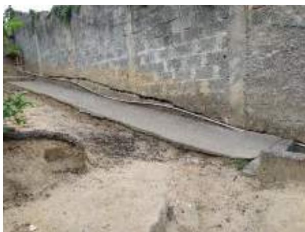
Imagem 5: Vista lateral da rampa existente.
