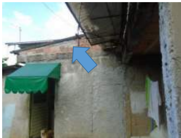
Imagem 64: Cobertura da cozinha que também deverá ser demolida (telhas, madeiramento e alvenaria).
