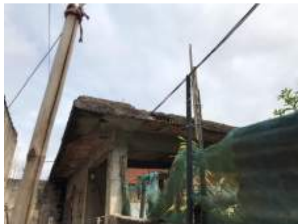
Imagem 291: Laje exposta, instalação de telhado de fibrocimento.
