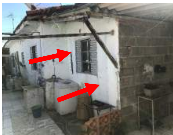
Imagem 100: Visão externa do Quarto 3, indicando a parede a ser ampliada e com visão da Janela J6 a ser reaproveitada.
