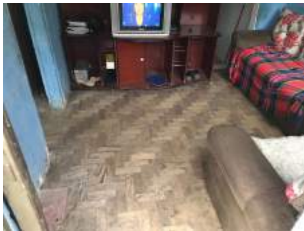
Imagem 272: Sala. Taco a ser removido
