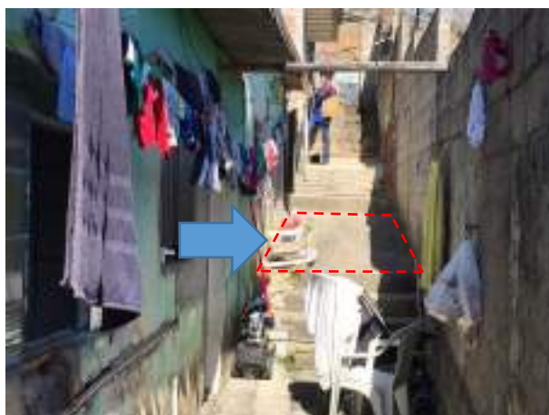
Imagem 56: Piso do corredor externo onde será instalada a segunda caixa de inspeção.
