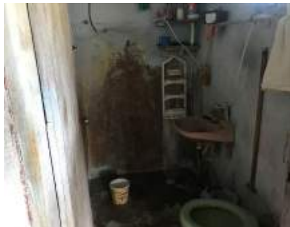
Imagem 226: Paredes internas do banheiro que serão contempladas com revestimento cerâmico.
