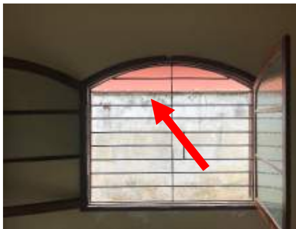
Imagem 298: Janela a ser substituída
