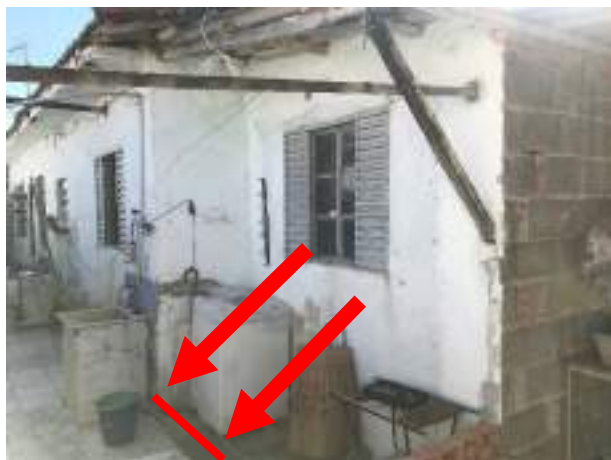
Imagem 102: Indicação do alinhamento da parede a ser construída.
