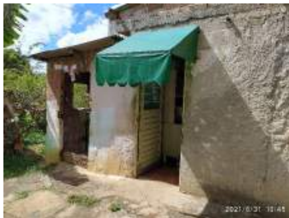
Imagem 78: Rebocar as paredes externas.
