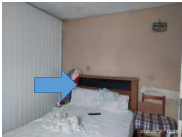
Imagem 83: Aplicar reboco impermeabilizante.
