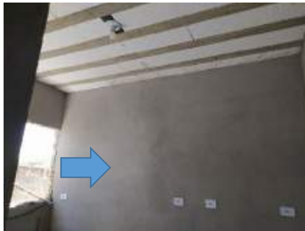
Imagem 37: Parede da cozinha da 1ª residência (da bancada da cuba) que receberá azulejo até o teto.
