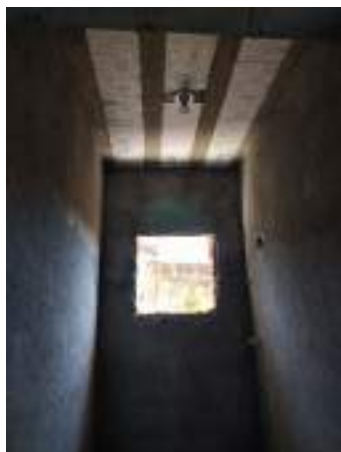
Imagem 40: Laje do banheiro da 1ª residência que receberá chapisco e emboço.
