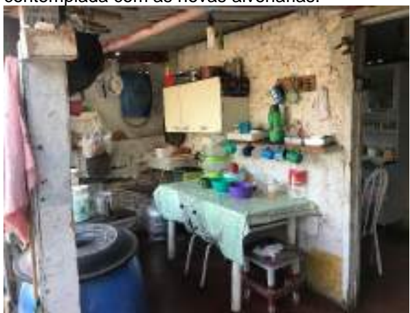
Imagem 220: Área prevista para fechamento de alvenaria.
