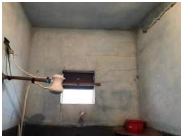
Imagem 290: Substituição da janela existente.
