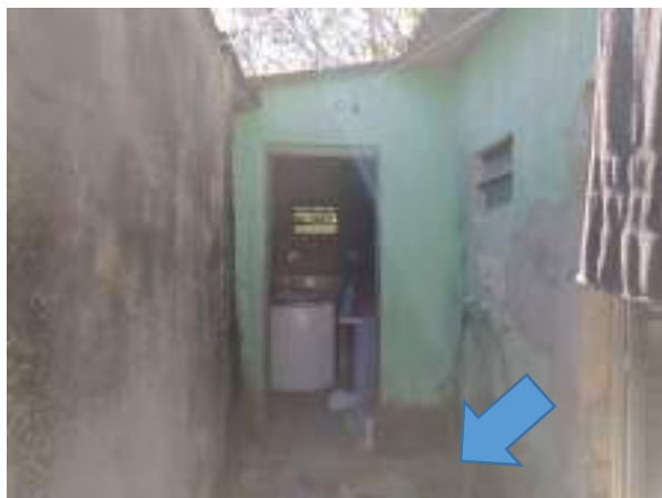
Imagem 23: Vista da porta da lavanderia e indicação de parte do piso que deverá ser demolido.
