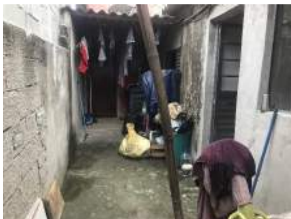
Imagem 194: Piso do corredor externo lateral à residência, onde será executado piso de concreto armado após a demolição do piso existente.
