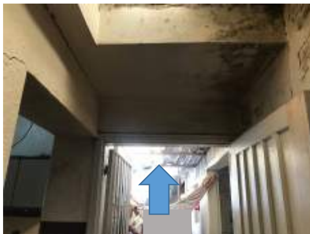
Imagem 172: Executar nova cobertura, com instalação de rufo, em frente à área de serviço.
