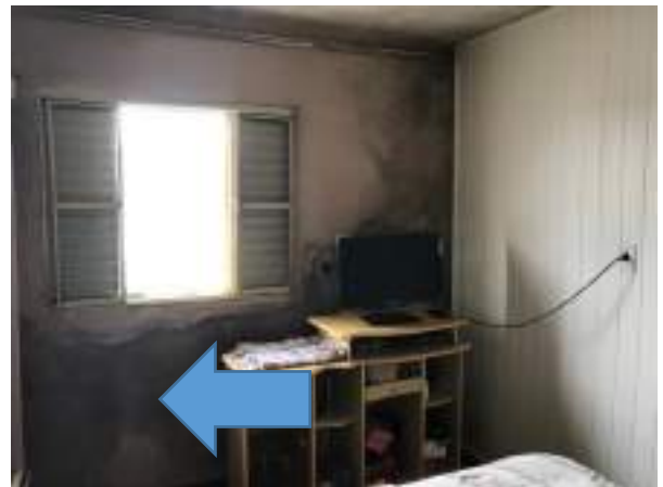
Imagem 68: Remover o reboco de maneira parcial, ver projeto.
