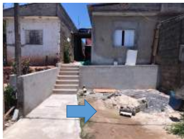
Imagem 195: Piso no recuo frontal do imóvel, que receberá piso de concreto armado.
