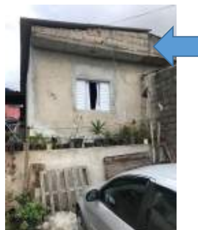
Imagem 191: Empena da fachada frontal a receber chapisco e emboço.
