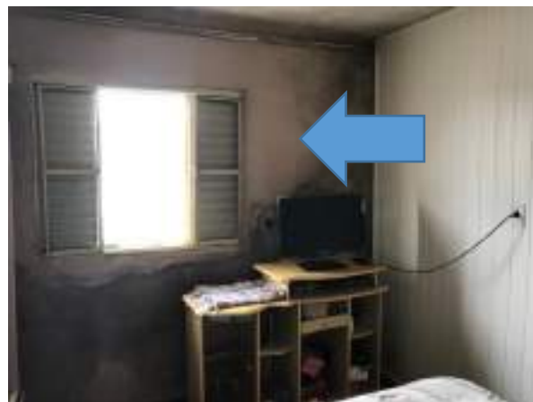
Imagem 72: Para instalação do quadro de distribuição, será necessária a demolição de uma pequena parcela de alvenaria.
