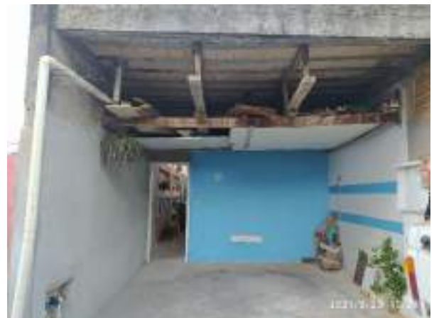
Imagem 321: Instalação de prateleiras na garagem.
