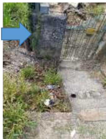
Imagem 11: Posição da execução do pilar da nova alvenaria do portão.
