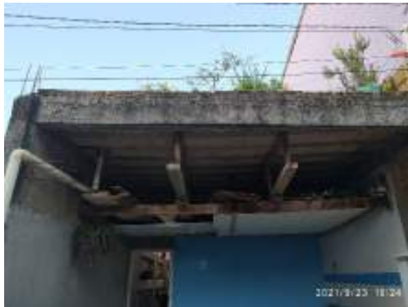
Imagem 310: Remoção da estrutura de madeira, com reaproveitamento.
