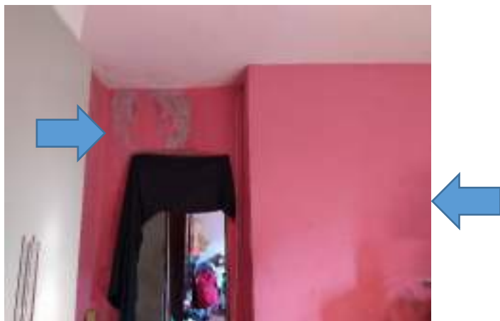
Imagem 19: Parede do dormitório 02 que receberá nova pintura.
