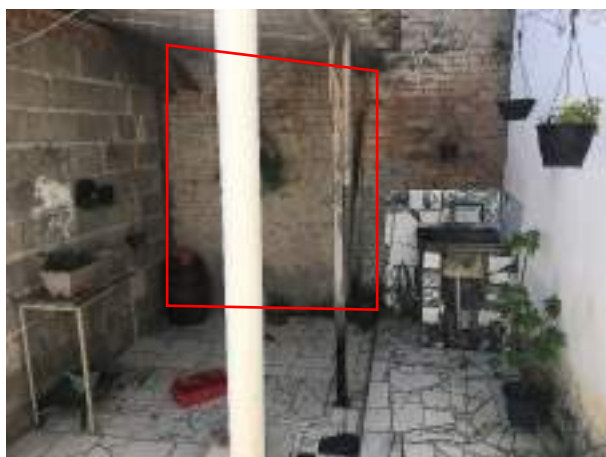
Imagem 104: Indicação da parede a ser construída.
