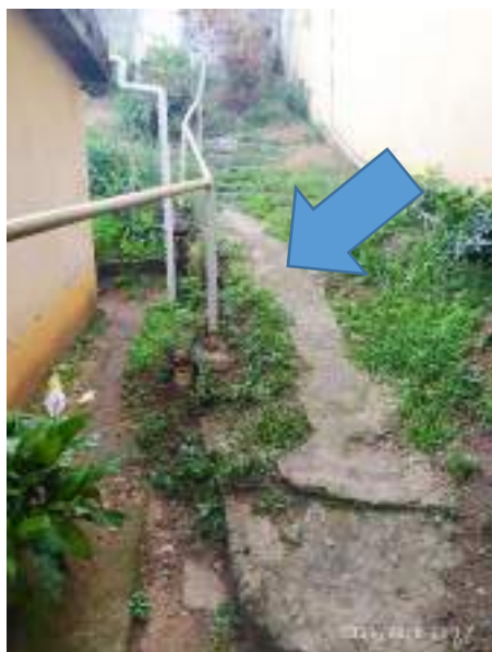
Imagem 73: Piso de concreto a ser demolido.
