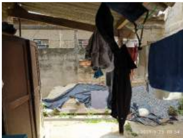
Imagem 253: Local onde será construída a mureta, esta deve seguir o contorno da estrutura de madeira (pilares) do telhado.
