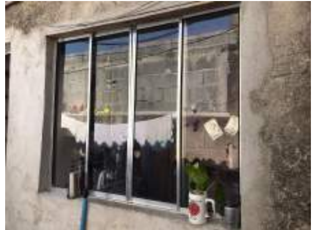
Imagem 181: Janela da cozinha a ser removida.
