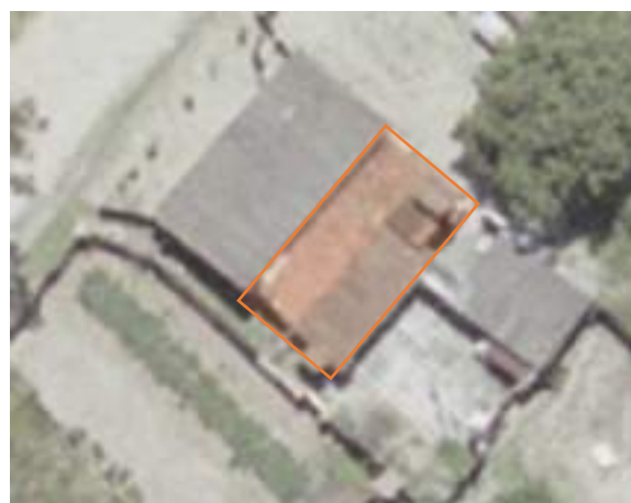
Imagem 224: Visão aérea da cobertura a ser edificada.
