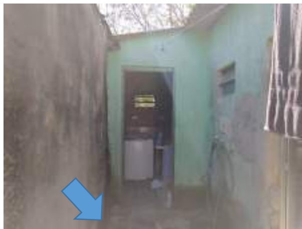
Imagem 51: Piso a ser executado (de concreto armado) entre a porta da cozinha e a lavanderia da última residência do lote.
