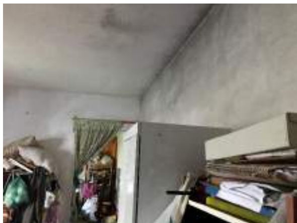
Imagem 140: Quarto 1, local a ser pintado após os reparos indicados.
