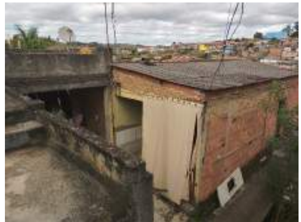
Imagem 235: Vista lateral do telhado a ser demolido.
