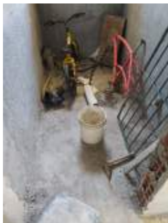
Imagem 45: Piso do banheiro da 1ª residência que receberá piso cerâmico (marca Cristalle, 0,45x0,45m).
