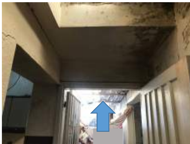
Imagem 161: Cobertura em frente à área de serviço a ser removida, sem reaproveitamento.
