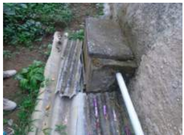
Imagem 70: Caixa de gordura a ser demolida.
