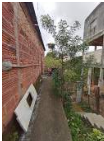
Imagem 245: Construir guarda-corpo em alvenaria.
