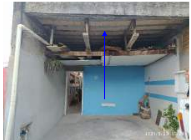
Imagem 317: Rebocar o teto e as demais frações de parede da garagem que não possuem esse tipo de acabamento.
