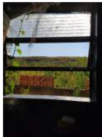
Imagem 8: Janela do banheiro a ser removida.
