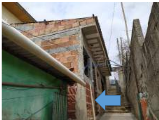
Imagem 54: Tubulação de esgoto já existente na parede externa da cozinha da 1ª residência.
