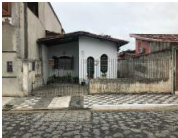
Imagem 296: Fachada do imóvel em questão e onde deve ser colocada a placa de obras.
