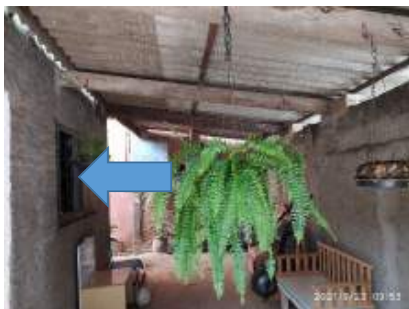
Imagem 262: Fachada frontal que receberá reboco.
