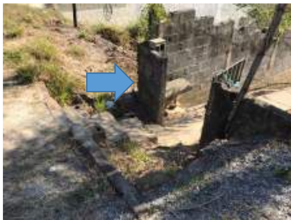
Imagem 3: Alvenaria do portão a ser demolida.
