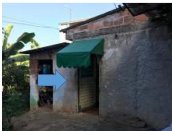
Imagem 89: Aplicar pintura de acabamento em toda a extensão desta face.
