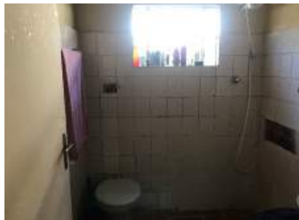
Imagem 121: Indicação do banheiro 1, onde serão substituídos os aparelhos sanitários.
