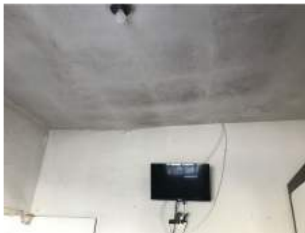
Imagem 162: Estuque do dormitório 01 a ser demolido.
