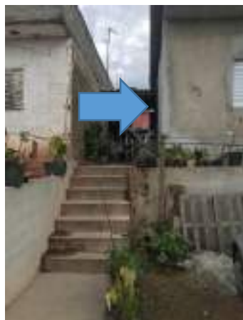
Imagem 204: Fachada lateral da residência que receberá pintura acrílica.
