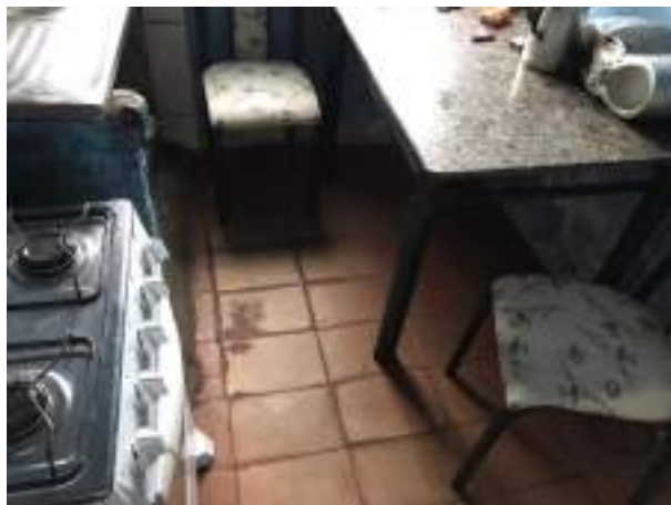
Imagem 274: Cozinha. Piso cerâmico a ser removido.
