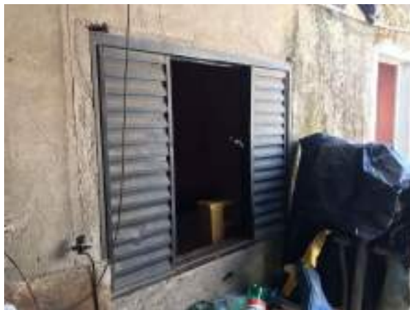
Imagem 182: Janela do dormitório 02 a ser removida.
