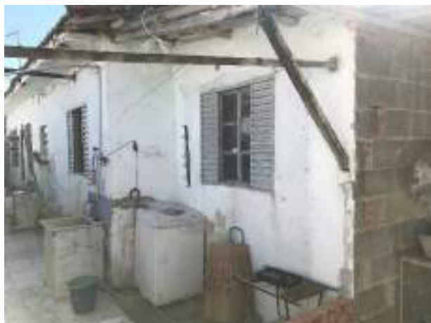
Imagem 106: Vista da Janela J6 a ser readequada.
