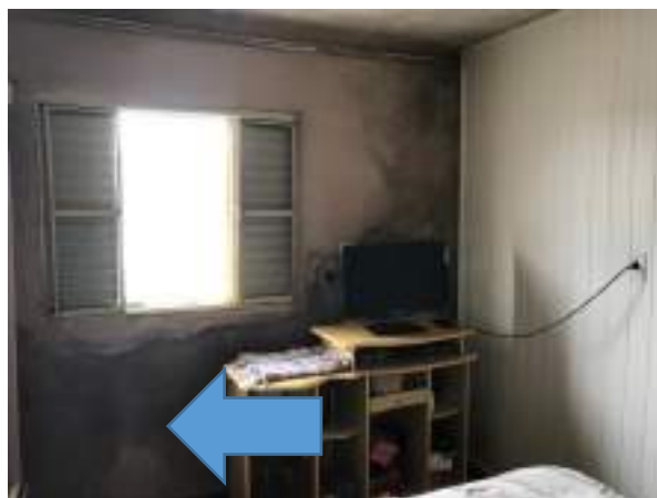
Imagem 82: Aplicar reboco impermeabilizante.
