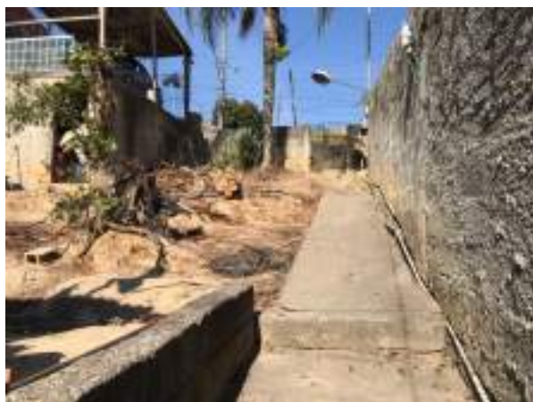
Imagem 1: Rampa e escadas existentes que serão aterradas.
