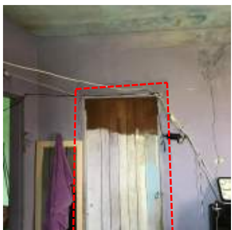
Imagem 286: Demolição de 5 cm da alvenaria ao redor das portas.
