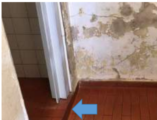
Imagem 146: Piso do banheiro 01 a ser demolido para quase nivelá-lo com o piso do corredor.
