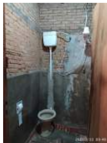
Imagem 269: Interior do banheiro.
