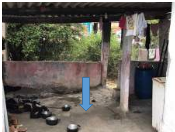
Imagem 283: Piso cerâmico a ser instalado.
