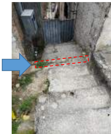
Imagem 44: Posição da nova alvenaria do portão na qual deverá ser aplicado chapisco e emboço.
