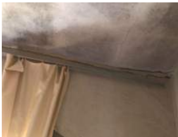
Imagem 163: Estuque do dormitório 02 a ser demolido.
