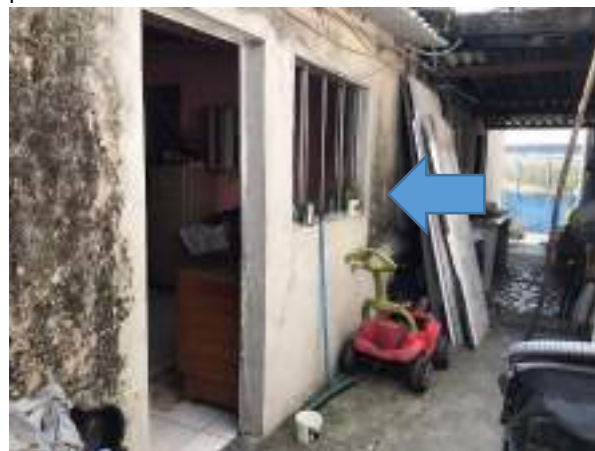
Imagem 203: Fachada lateral da residência que receberá pintura acrílica.
