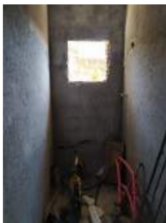
Imagem 38: Paredes do banheiro da 1ª residência que receberão azulejos até a altura de 1,60m (marca Realce, 0,32x0,56m).
