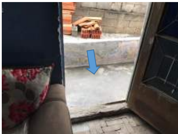
Imagem 282: Piso cerâmico a ser instalado.
