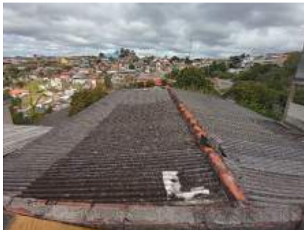
Imagem 234: Telhado e alvenaria de cobertura a ser removido/demolido. Esta área contempla dormitórios, sala, banheiro e cozinha.
