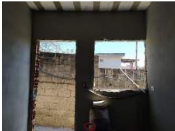
Imagem 36: Parede da cozinha da 1ª residência que receberá azulejo até o teto.
