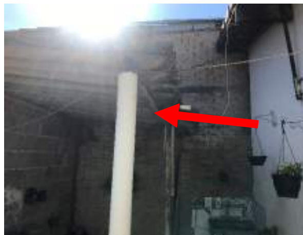
Imagem 96: Vista do telhado da área de serviço que será requalificado juntamente com a cobertura do Quarto 3.
