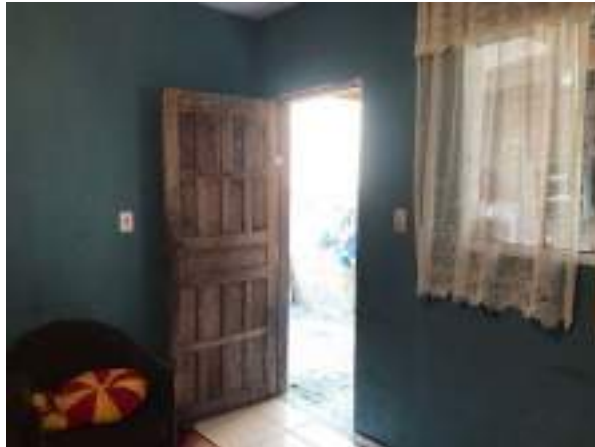
Imagem 180: Porta de madeira da sala a ser removida.
