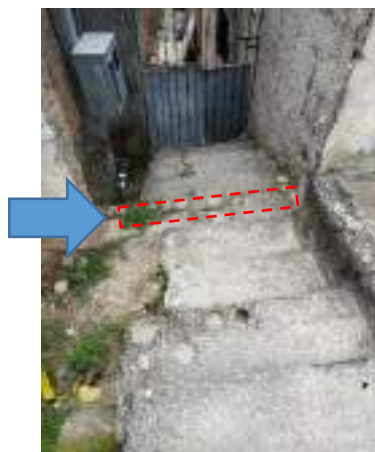
Imagem 28: Posição da nova alvenaria do portão a ser executada (ver projeto arquitetônico).
