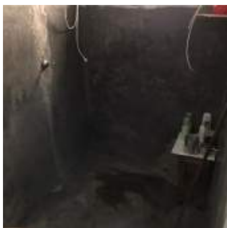
Imagem 292: Instalação de barra impermeável em todo banheiro.
