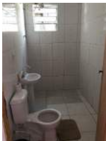
Imagem 196: Banheiro a receber o kit de acessórios e o box de vidro e alumínio branco.
