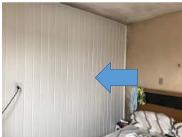
Imagem 81: Aplicar reboco impermeabilizante.
