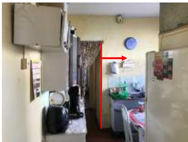
Imagem 114: Parede da cozinha que será revestida com azulejo, com o início da BI a partir do acesso ao banheiro.
