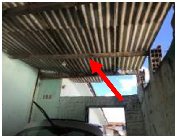
Imagem 95: Vista do Telhado da Garagem a ser requalificado.
