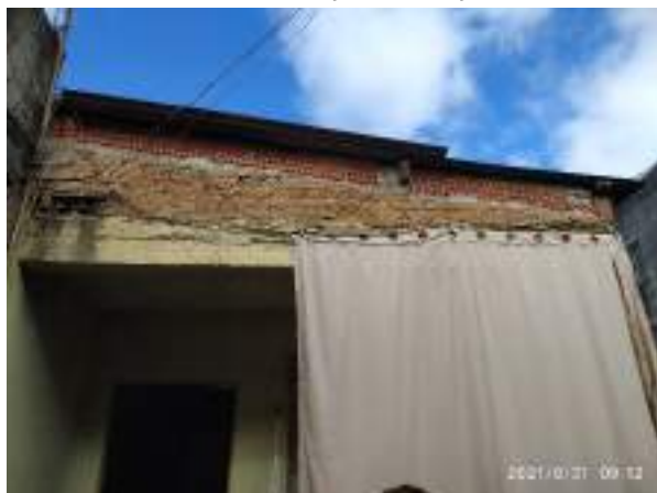
Imagem 238: Retirar cabos elétricos para execução dos serviços.
