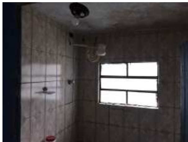
Imagem 277: Banheiro. Plafonier ser removido.
