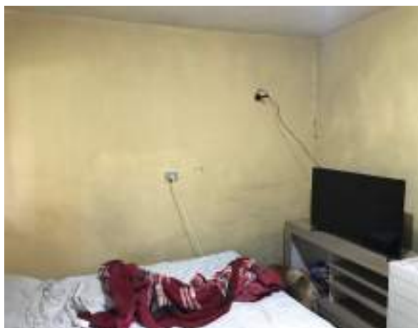
Imagem 142: Quarto 3, local a ser pintado após os reparos indicados.
