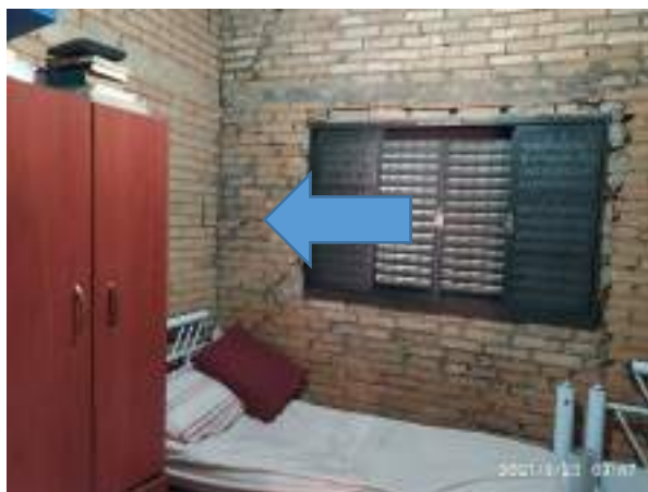
Imagem 258: Dormitório 1 a ser rebocado.
