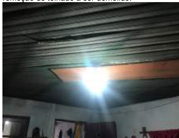
Imagem 214: Visão geral do Forro do Quarto 1 a ser removido..
