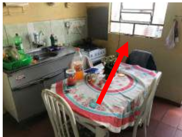
Imagem 115: Parede da cozinha que receberá revestimento cerâmico.
