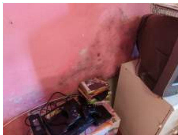
Imagem 10: Argamassa a ser demolida da parede do dormitório 02 que faz divisa com o banheiro.
