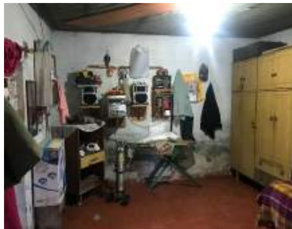
Imagem 233: Paredes internas que receberão pintura.
