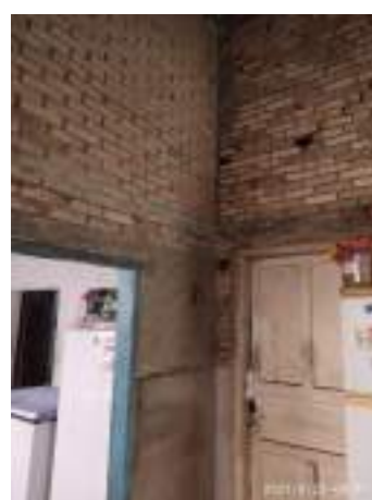
Imagem 271: Cozinha, área que receberá reboco e pintura de acabamento.
