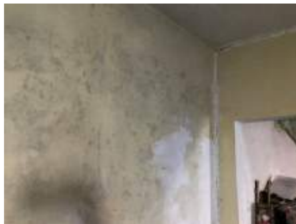
Imagem 141: Quarto 2, local a ser pintado após os reparos indicados.
