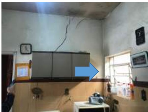
Imagem 147: Janela existente na cozinha que terá seu vão aumentado.
