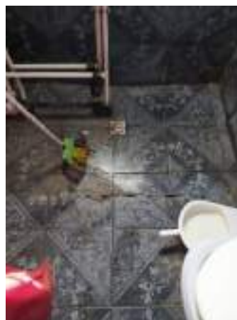
Imagem 2: Piso do box do banheiro que receberá um pequeno aterro.
