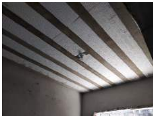
Imagem 43: Laje do dormitório da 1ª residência que receberá gesso.
