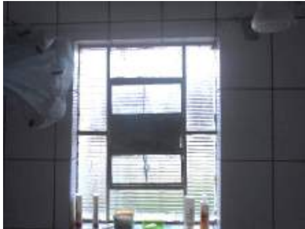
Imagem 65: Janela do banheiro a ser removida, sem reaproveitamento.
