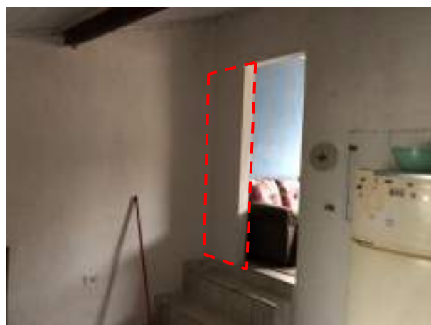
Imagem 281: Parede a ser removida.
