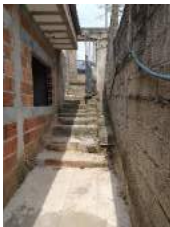
Imagem 21: Escada existente (vista de dentro do lote) que será aterrada.
