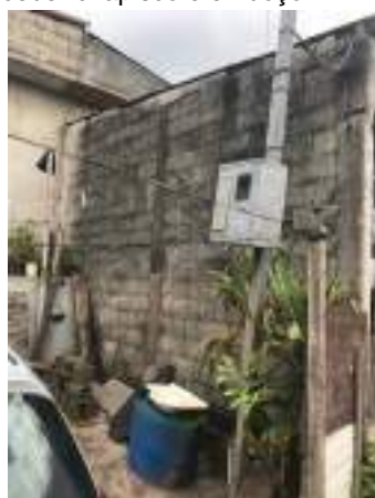
Imagem 192: Muro de divisa, no recuo frontal, com o vizinho do lado direito de quem da rua olha para a residência que receberá chapisco e emboço.
