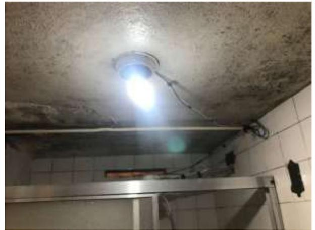
**Imagem 158:** Demolir a argamassa da laje do banheiro 01.
