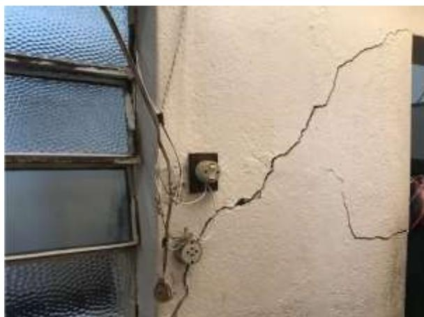
**Imagem 170:** Trincas e rachaduras no corredor em frente ao banheiro 01.
