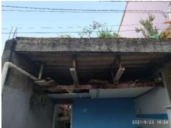
**Imagem 310:** Remoção da estrutura de madeira, com reaproveitamento.
