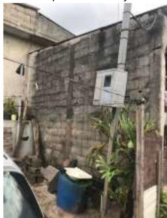
**Imagem 192:** Muro de divisa, no recuo frontal, com o vizinho do lado direito de quem da rua olha para a residência que receberá chapisco e emboço.
