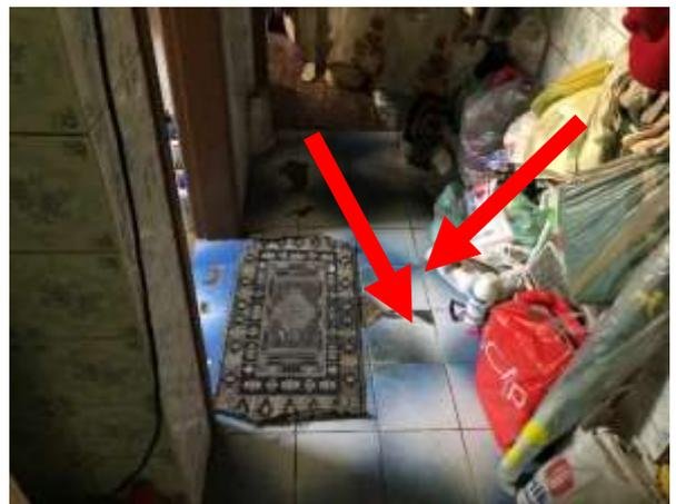
**Imagem 131:** Indicação do piso da cozinha para substituição.
