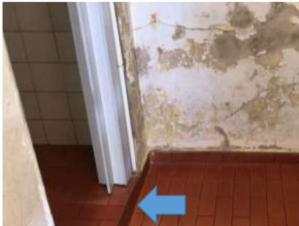
**Imagem 146:** Piso do banheiro 01 a ser demolido para quase nivelá-lo com o piso do corredor.
