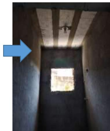
**Imagem 39:** Parte superior das paredes do banheiro da 1ª residência que receberão emboço interno desempenado para pintura.
