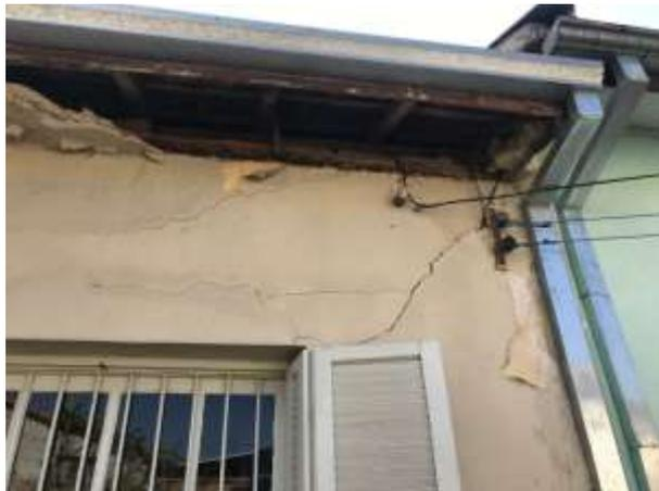
**Imagem 168:** Exemplo de trincas e rachaduras na fachada frontal da residência.
