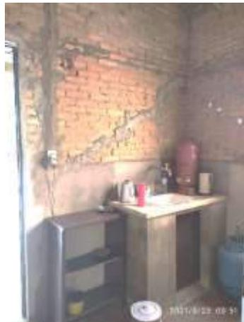
**Imagem 251:** Parede da cozinha com argamassa (cimento queimado) a ser demolida e que receberá, na sequência, reboco e revestimento cerâmico.
