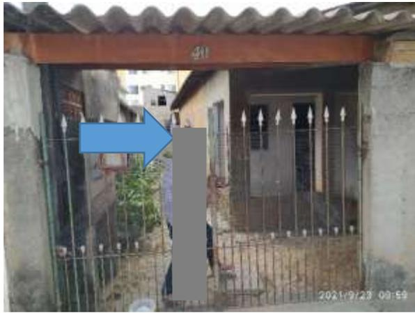
**Imagem 260:** Fachada lateral (esquerda) da residência, deve receber reboco ao longo de toda a sua área.
