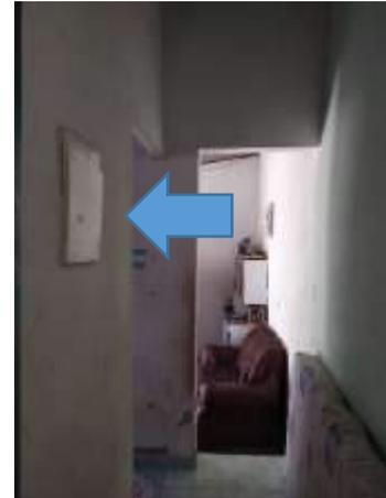
**Imagem 59:** Quadro de distribuição de energia existente na 2ª residência.
