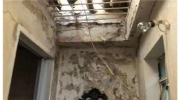
**Imagem 156:** Demolir a argamassa das 03 (três) paredes do corredor em frente ao banheiro 01.
