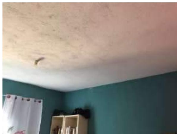
**Imagem 179:** Laje do dormitório 01, que deverá ter todo o seu revestimento removido.
