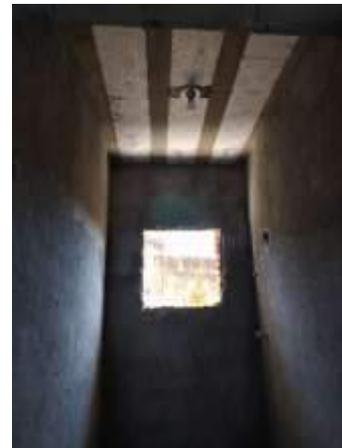
**Imagem 25:** Vista da janela da 1ª residência que terá seu vão aumentado de 0,60x0,60m para 0,80x 0,80m para a instalação da janela.
