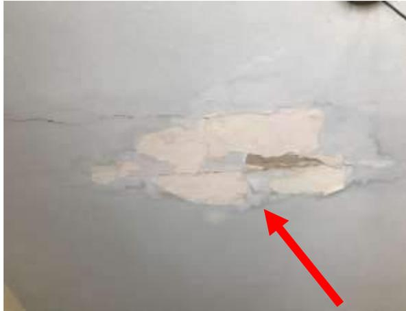
**Imagem 302:** Pintura descolando e trinca identificadas no teto da sala que será reparada.
