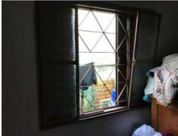
**Imagem 126:** Vista da Janela J6 no Quarto 2 para substituição.
