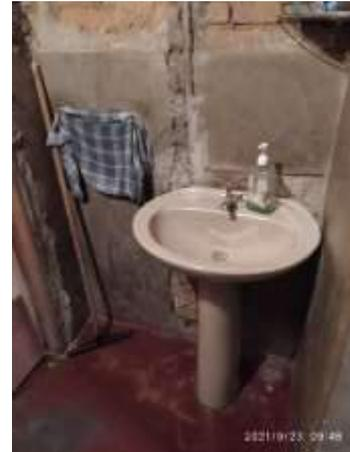
**Imagem 267:** Interior do lavabo – barra impermeável até 1,5m e pintura no restante da área (acima de 1,5m).
