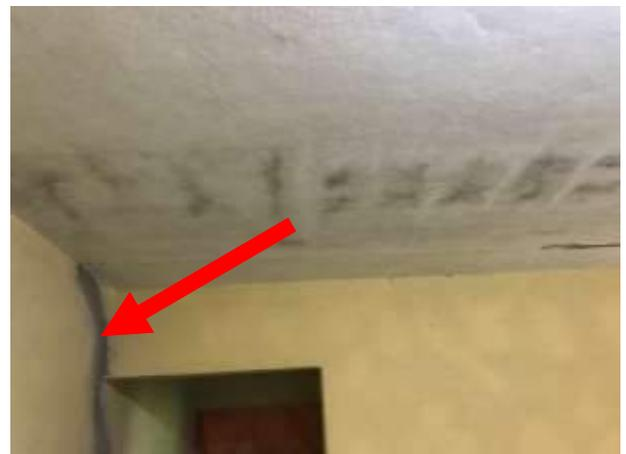
**Imagem 134:** Indicação de uma das trincas a ser reparada no Quarto 3.
