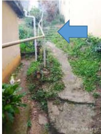
**Imagem 90:** A escada a ser refeita irá iniciar a partir do trecho em destaque e terminará nas proximidades da residência.
