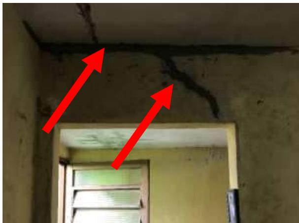
**Imagem 133:** Indicação de uma das trincas a ser reparada no Quarto 3.
