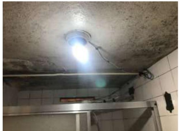
**Imagem 154:** Deverá ser removido todo o revestimento de azulejo existente no banheiro 01.
