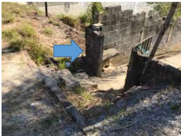
**Imagem 3:** Alvenaria do portão a ser demolida.
