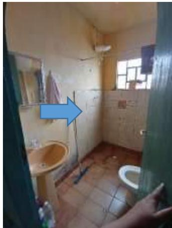
**Imagem 246:** Instalar barra de apoio no box do chuveiro.
