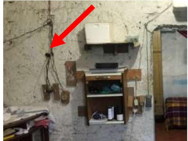
**Imagem 210:** Detalhes para fiação exposta que ocorre em todo imóvel.
