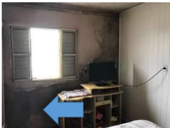
Imagem 82: Aplicar reboco impermeabilizante.
