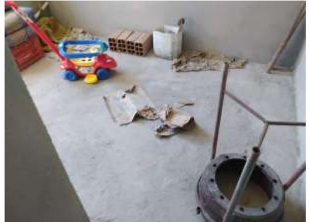
**Imagem 46:** Piso da cozinha da 1ª residência que receberá piso cerâmico (marca Unigress, 0,54x0,54m) e rodapé.
