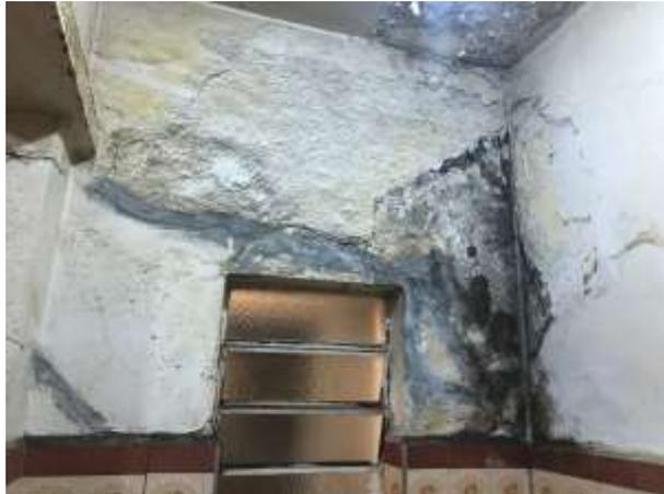
**Imagem 166:** Janela J5 da cozinha que será removida e seu vão deverá ser fechado com blocos vazados de concreto.
