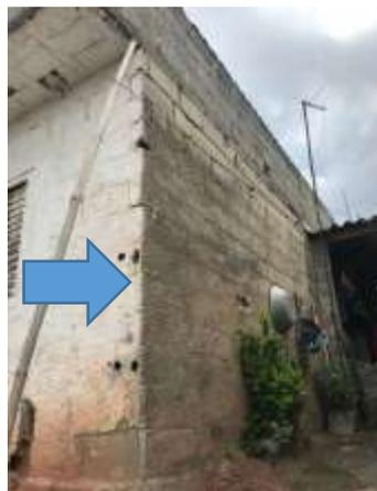
**Imagem 188:** Muro de divisa com o vizinho do lado esquerdo de quem da rua olha para a residência a receber chapisco e emboço.
