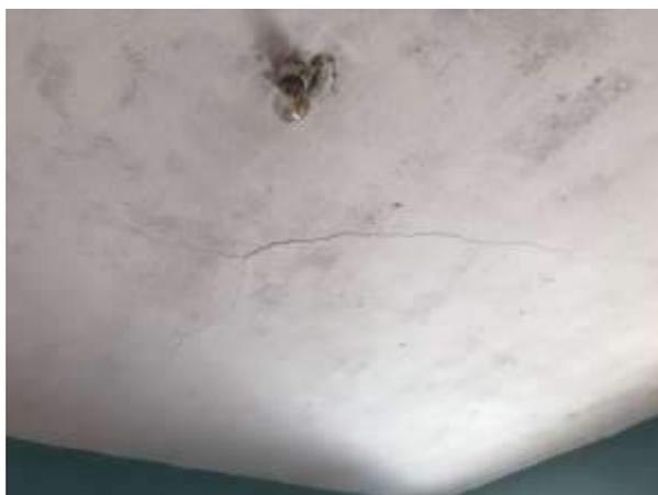
**Imagem 178:** Laje da sala, que deverá ter todo o seu revestimento removido. Assim como a laje em frente ao banheiro.
