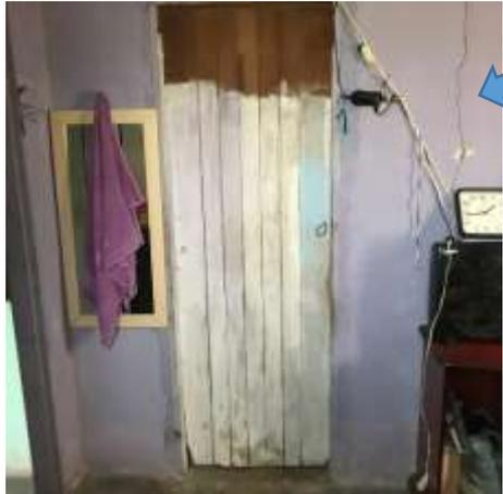
**Imagem 284:** Porta (folha e batente) a ser removido. Atentar-se a fragilidade da parede, conforme trinca evidenciada.
