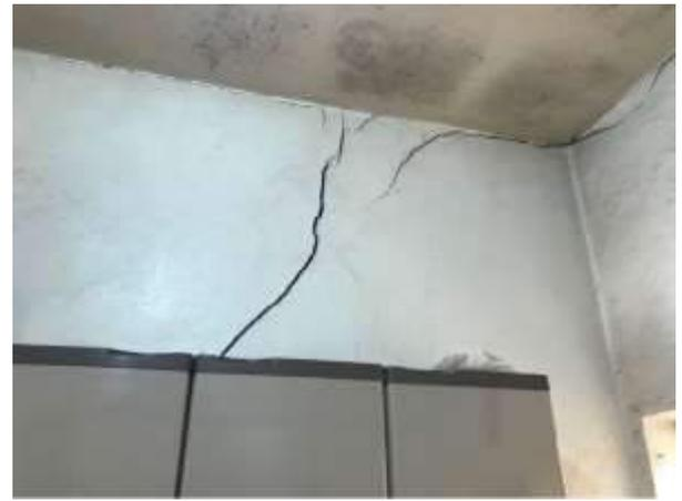
**Imagem 169:** Exemplo de trincas e rachaduras na cozinha.
